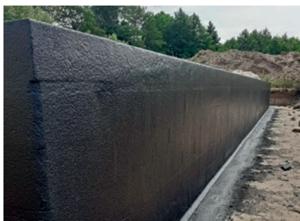
Izolacja fundamentu wykonana za pomocą masy KMB.
