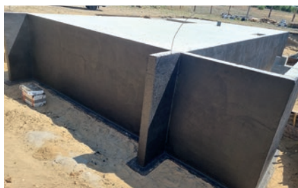
Izolacja budynku jednorodzinnego.
