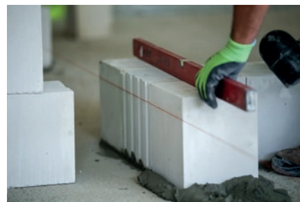
Poprawne wykonanie pierwszej warstwy ma kluczowe znaczenie dla jakości całej przegrody.
