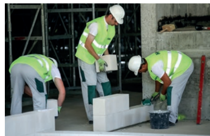
Prace murarskie przy użyciu elementów silikatowych najlepiej wykonywać w ekipach trzyosobowych.
