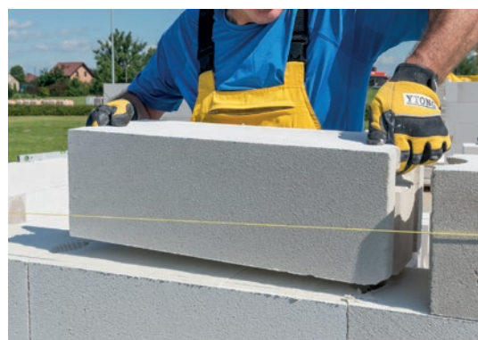
Wykonywanie ścian z bloczków betonu komórkowego przebiega bardzo sprawnie i szybko.
