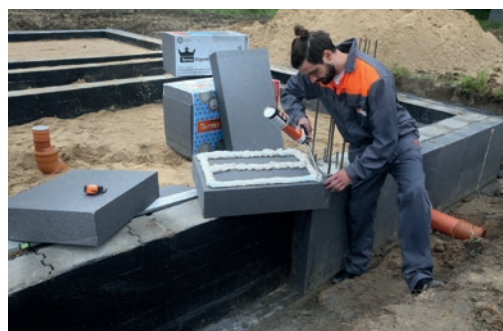
Nakładanie kleju poliuretanowego.
