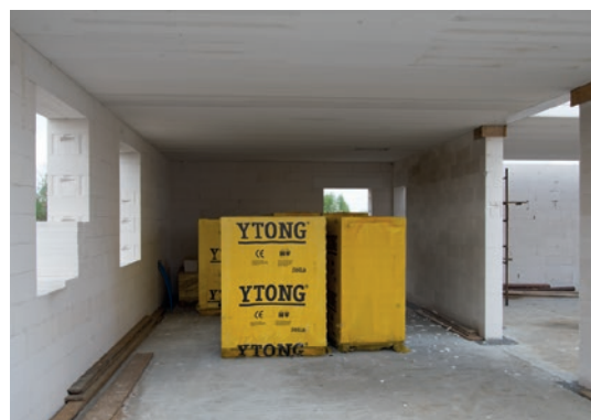
Wykonywanie ścian z bloczków betonu komórkowego przebiega bardzo sprawnie i szybko.
