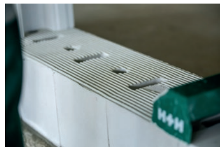
Poprawne wykonawstwo to również zadbanie o odpowiednie rozłożenie zaprawy.
