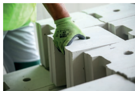
Bloczki silikatowe posiadają uchwyty pozwalające na ich łatwe przenoszenie i ustawianie w warstwie muru.
