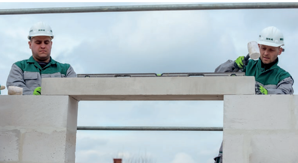
Stosowanie prefabrykowanych nadproży z betonu komórkowego eliminuje konieczność wykonywania szalunków oraz planowania przerw technologicznych na czas wiązania betonu.
