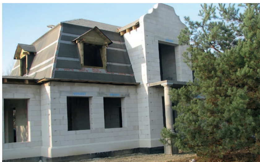
Precyzyjnie wykonane mury jednowarstwowe na zaprawę murarską do cienkich spoin
