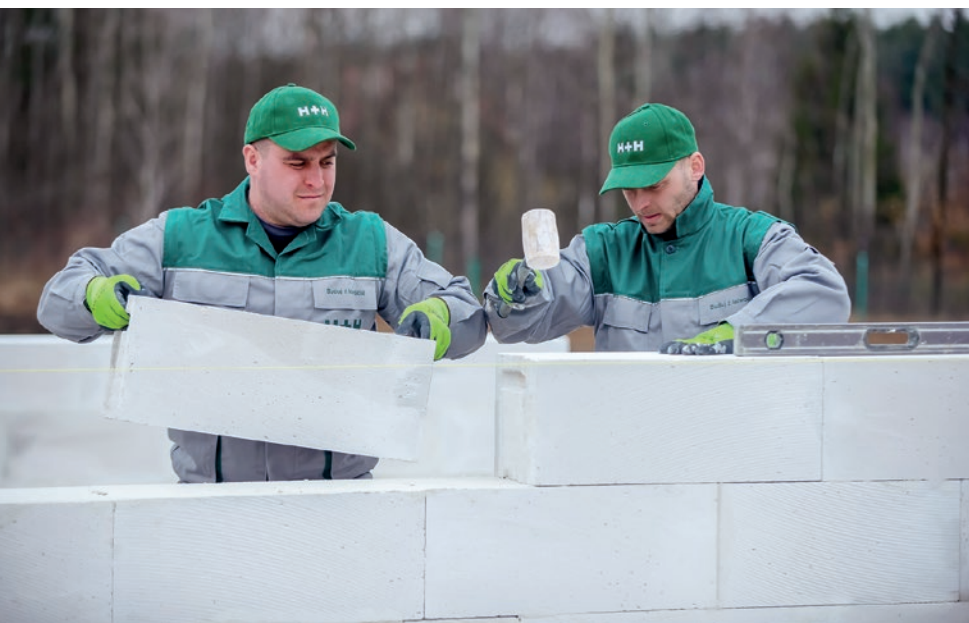
Korekty ustawienia elementów w warstwie należy wykonywać przy użyciu odpowiednich narzędzi np. młotka gumowego.
