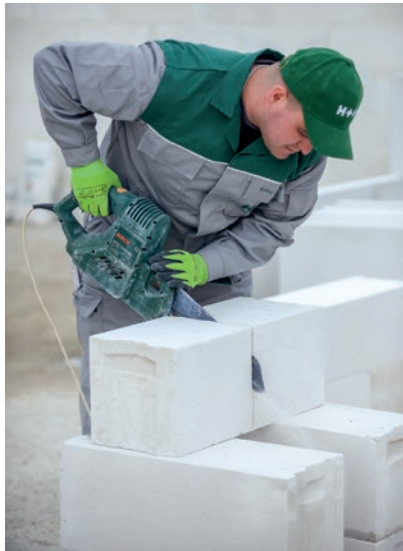
Elementy z betonu komórkowego można łatwo docinać do odpowiednich wymiarów.
