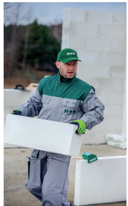
Bloczki z betonu komórkowego są lekkie, ich transport wewnętrzny na budowie nie przysparza wykonawcom problemów.
