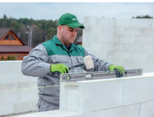
Murując należy kontrolować poziom układanych warstw, ewentualnych korekt dokonując młotkiem gumowym.
