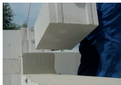
Murowanie na zaprawę murarską do cienkich spoin
