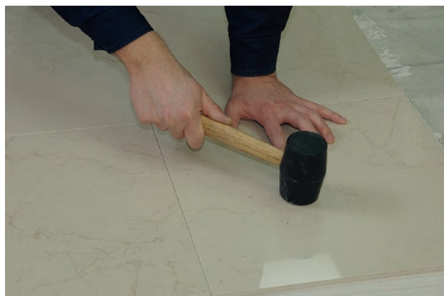
Montaż płytki kamiennej
