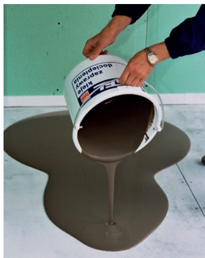
Wylewanie wylewki samopoziomującej
