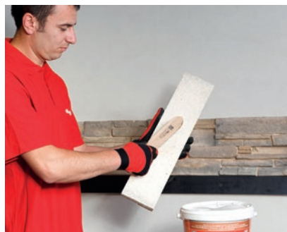
3 Czyszczenie powierzchni klejonej płytek
