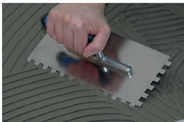
Nakładanie kleju
