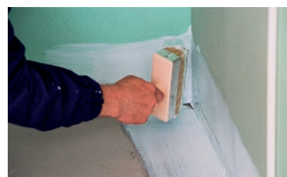
Montaż taśmy uszczelniającej w narożniku – nanoszenie płynnej folii
