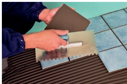
Nakładanie kleju na spodnią stronę płytki
