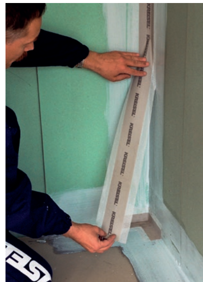
Przyklejanie taśmy uszczelniającej
