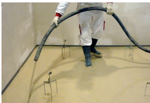
Układania masy samopoziomującej
