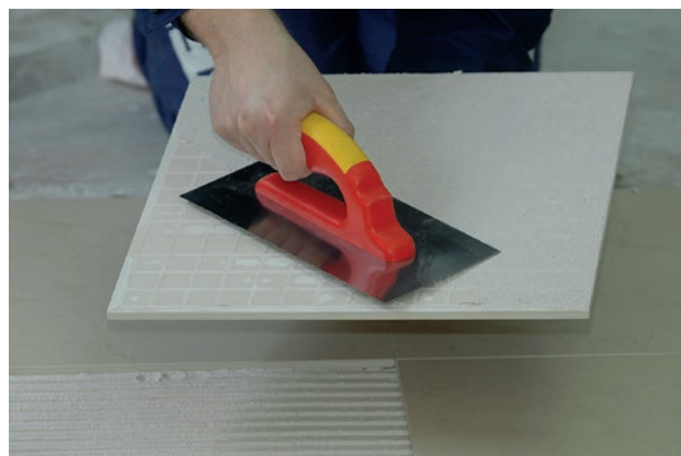
Smarowanie spodniej strony dużej płytki
