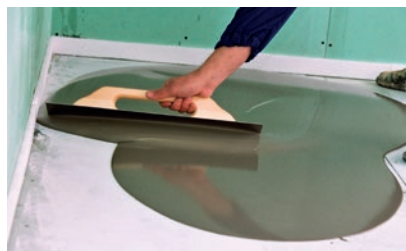
Rozprowadzanie wylewki samopoziomującej
