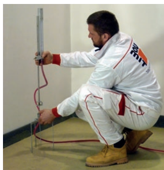
Niwelacja podłoża
