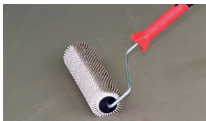
Odpowietrzanie wylewki samopoziomującej
