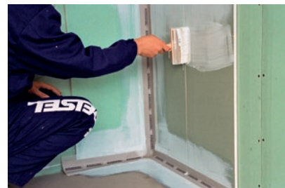
Wykonywanie izolacji z płynnej folii
