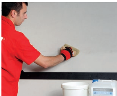
2 Gruntowanie podłoża
