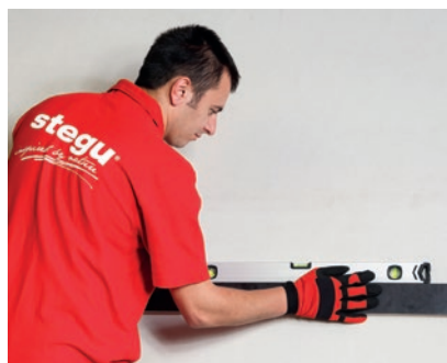
1 Wyznaczanie poziomu ścian
