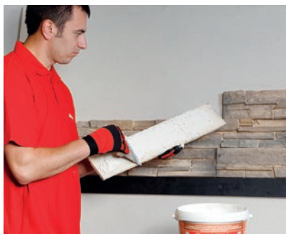
4 Nakładanie kleju montażowego
