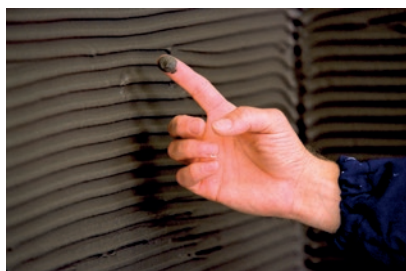
Sprawdzanie czasu otwartego kleju
