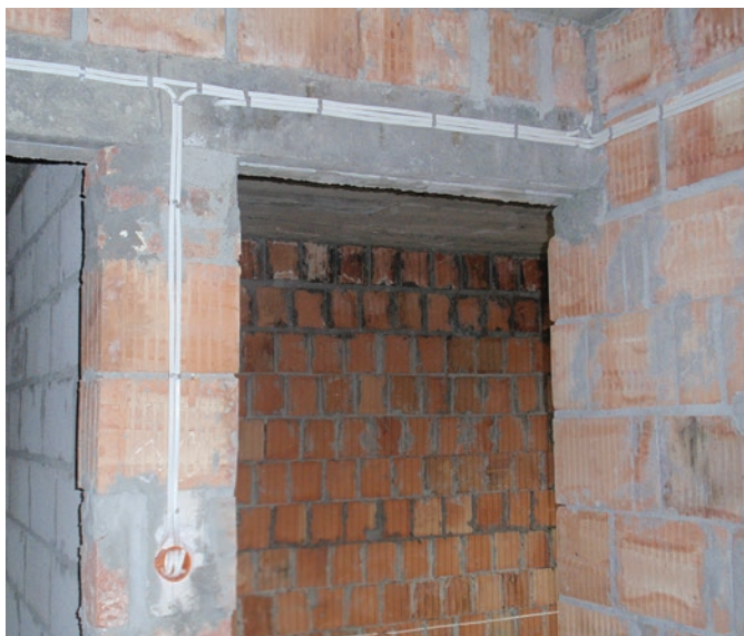
Przewód ułożony na taśmach aluminiowych.
