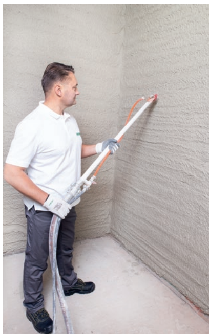
Aplikacja maszynowa zapewnia szybki postęp prac
