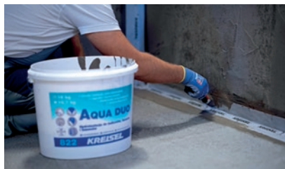
Montaż taśmy uszczelniającej
