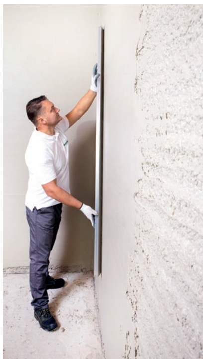
Lekka obróbka wpływa na jakość i wydajność prac tynkarskich
