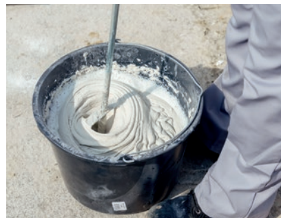
Mieszadło do zaprawy cienkowarstwowej umożliwia przygotowanie zaprawy o pożądanym parametrach.
