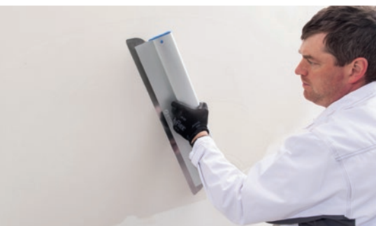
Wygładzanie powierzchni przy użyciu gładzi. Można uzyskać powierzchnię o najwyższym poziomie jakości Q4 (wg klasyfikacji poziomów Q1-Q4 wykończenia powierzchni Europejskiego Stowarzyszenia Przemysłu Gipsowego Eurogypsum).
