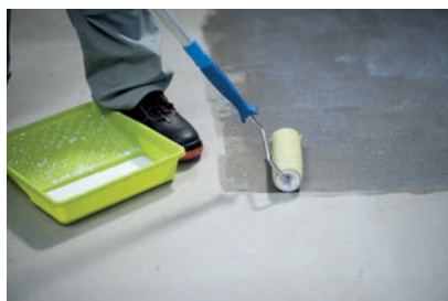
Grunтовanie podłoża
