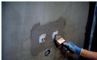
Uszczelnienie przejść instalacyjnych
