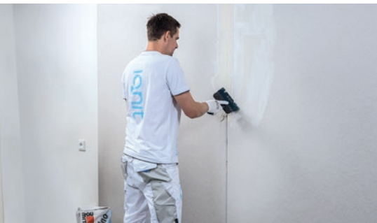
Szpachlowanie połączeń płyt g-k (należy pamiętać o wzmocnieniu połączeń np. odpowiednią taśmą).
