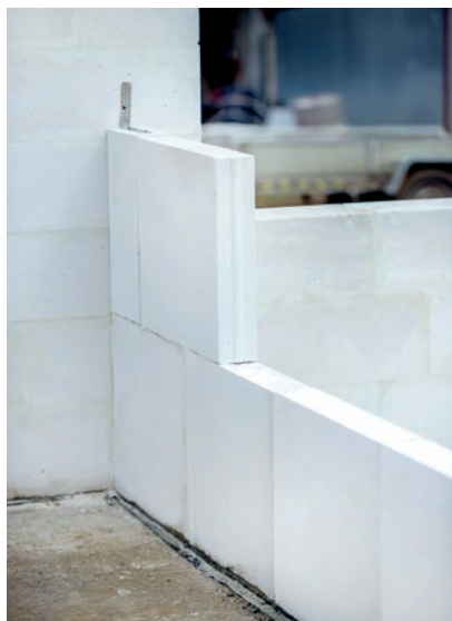
Z paneli o powiększonych wymiarach szybko i sprawnie powstają ściany działowe.
