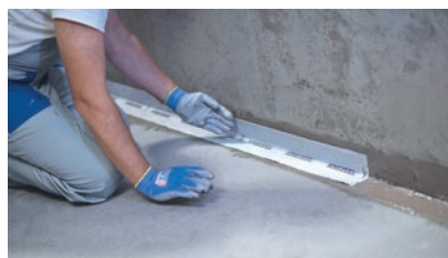
Wklejanie taśmy uszczelniającej
