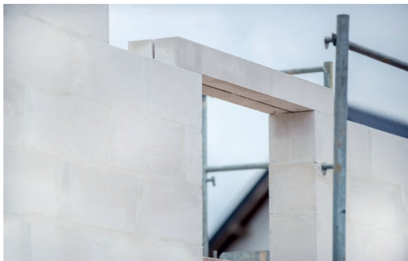
Nadproża z betonu komórkowego są uzupełnieniem konstrukcji, które nie wymaga przerwy technologicznej.
