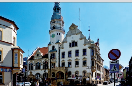
Ratusz w Kamiennej Górze (wpisany do rejestru zabytków). Roboty wykonane przez Rokom obejmowały renowację zabytkowej elewacji budynku, budowę szybu windy wraz z jej montażem oraz wykonanie iluminacji budynku.
