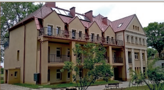
Dziecięcy Szpital Uzdrawiskowy „Mieszko” w Szczawnie-Zdroju (obiekt wpisany do rejestru zabytków). Prace Rokom polegały na kompleksowym remoncie budynku i obejmowały docieplenia, wymianę pokrycia dachu, roboty wykończeniowe, montaż windy, wymianę stolarki, roboty sanitarne (instalacja solarna, c.o. wentylacji, kanalizacji), elektryczne (instalacje RTV, przyzywowa, oświetlenia, systemu sygnalizacji alarmu pożaru).
