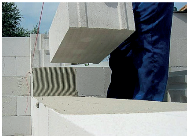
Wysoka dokładność wymiarowa bloczków SOLBET sprawia, że powstający mur nie wymaga niwelowania nierówności poprzez zastosowanie grubej spoiny. Jej grubość może być więc ograniczona do minimum.
