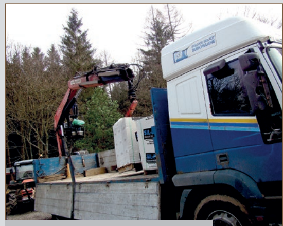
Rozładunek bloczków z firmy Pagaz na placu budowy realizowanej przez Rokom w Krzeszowie.
