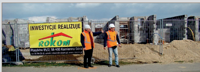
Henryk Komorowski i Grzegorz Komorowski czekają na podwykonawcę. Budowa szeregowca w Jaworze.
