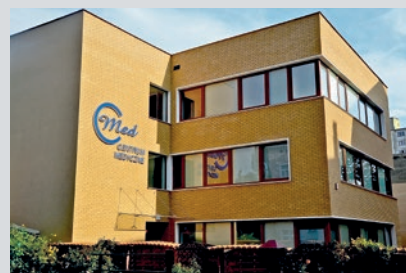
Centrum Medyczne Med w Legnicy – wzniesione przez Rokom wraz z wykonaniem wszystkich robót wykończeniowych.
