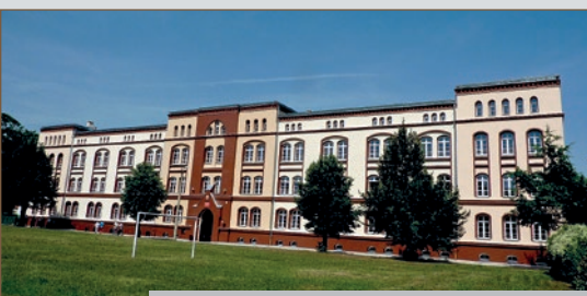
Gimnazjum nr 3 w Świdnicy. Prace wykonane przez Rokom polegały na kompleksowej termomodernizacji budynków Gimnazjum, w tym docieplenia elewacji, stropodachów, wymiana stolarki okiennej i drzwiowej, wymiana instalacji c.o. oraz liczne prace wykończeniowe wewnątrz.
