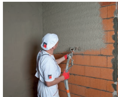
Narzucanie tynku maszynowego agregatem.
