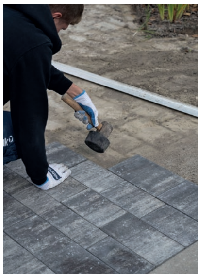
Układanie kostki brukowej od krawędzi do środka
