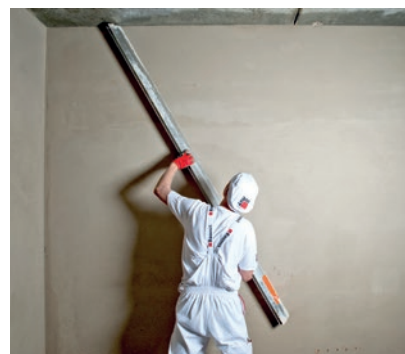
Wyrównywanie powierzchni łatą.
