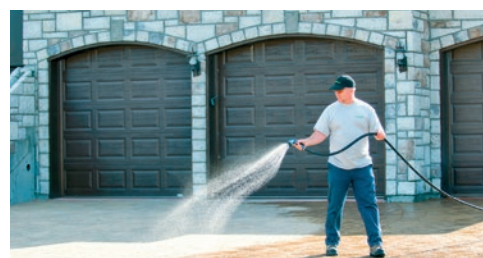
Czyszczenie kilkuletniej nawierzchni za pomocą myjki ciśnieniowej.
