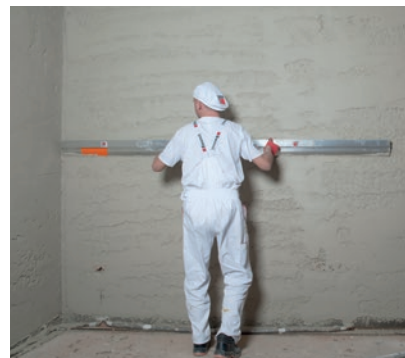
Ściąganie tynku łatą po narzuceniu na ścianę.
