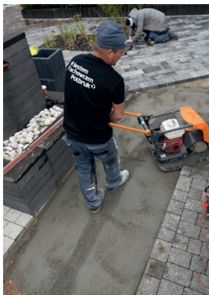
Zagęszczenie dna i podbudowy
