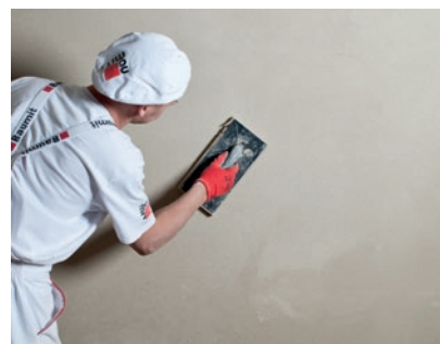
Zacieranie końcowe powierzchni tynku pacą z twardej gąbki.
