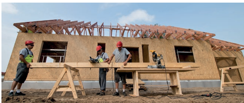
Budowa domu w konstrukcji szkieletu drewnianego.
