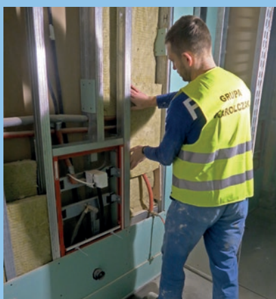
Zabudowa wodoodporną płytą g-k ścianki instalacyjnej w toalecie. Pracownik układa wełnę skalną w celu poprawienia izolacyjności akustycznej ścianki.
