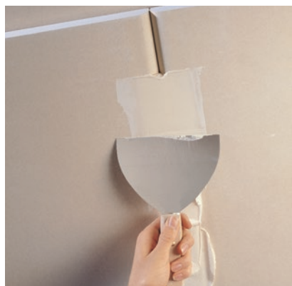
Spoinowanie połączeń płyt gipsowo-kartonowych.
