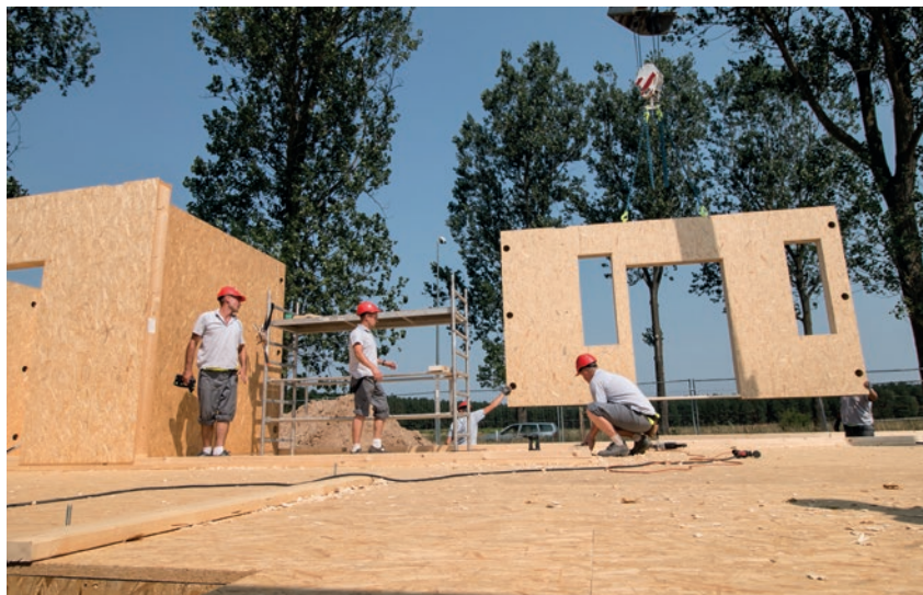
Montaż prefabrykowanych elementów ścian domu szkieletowego.
