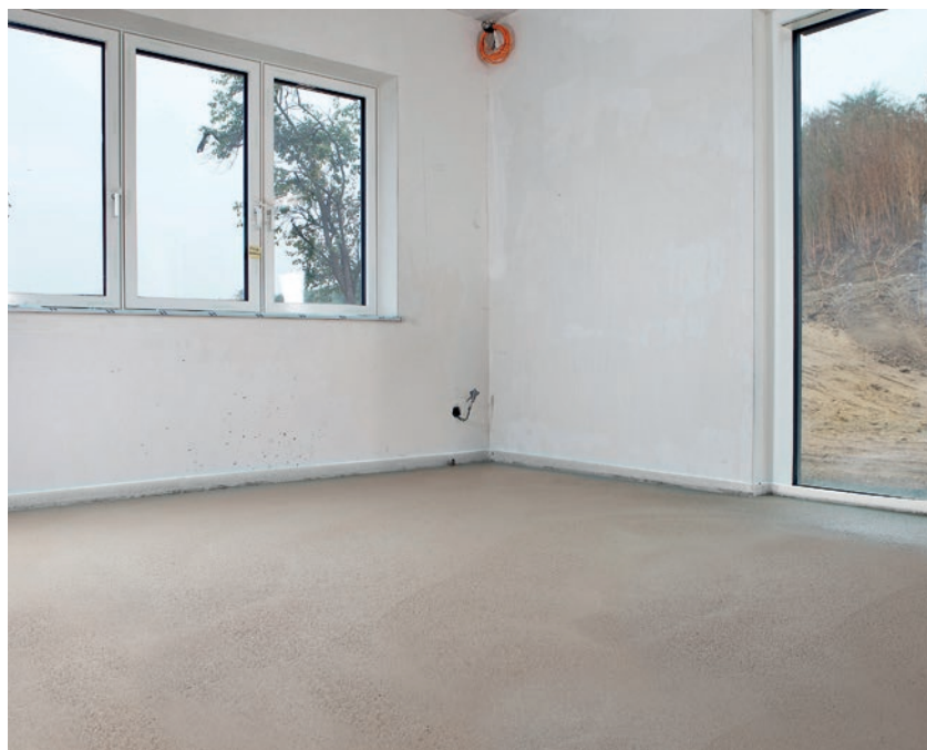
Gotowy podkład pod warstwę wykończeniową.
