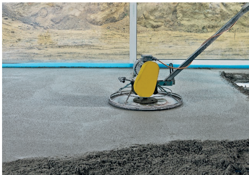
Zastosowanie zacieraczki elektrycznej pozwala na gładkie wykończenie powierzchni.
