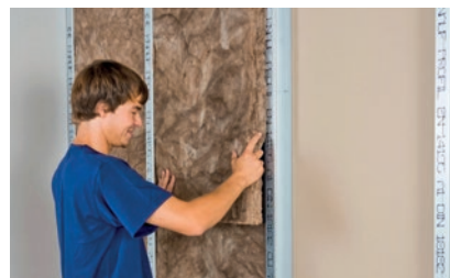
Układanie wełny mineralnej.
