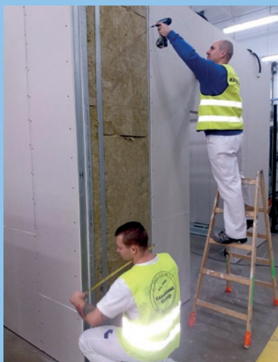
Prace przy konstrukcji ścianki działowej wypełnionej wełną skalną Rockwool. Wkręcanie wkrętów i domierzanie szerokości płyty przed jej docięciem.
