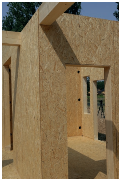
Płyty OSB na poszyciu ścian w budynku szkieletowym.
