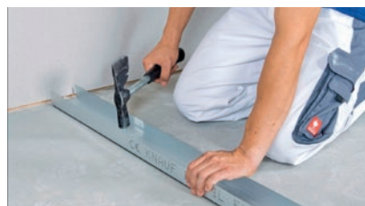
Montaż profili obwodowych UW do podłogi.
