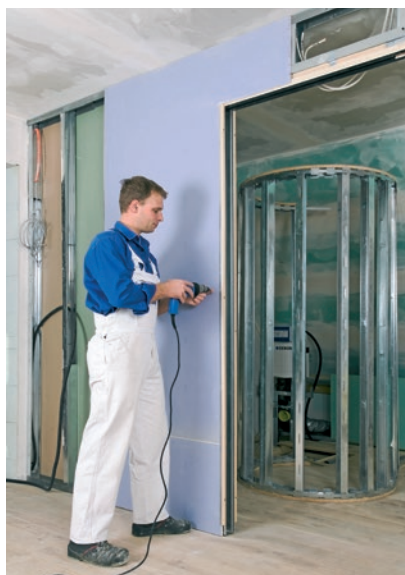
Montaż płyt gipsowo-kartonowych.
