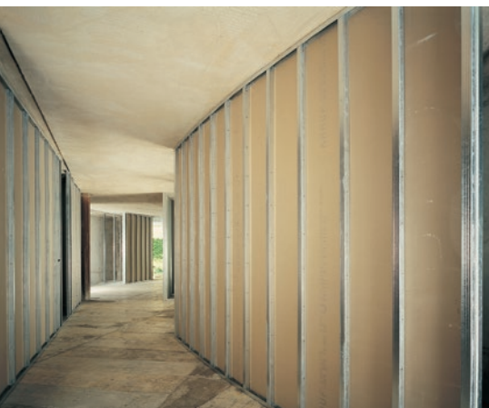
Konstrukcja ściany szkieletowej.
