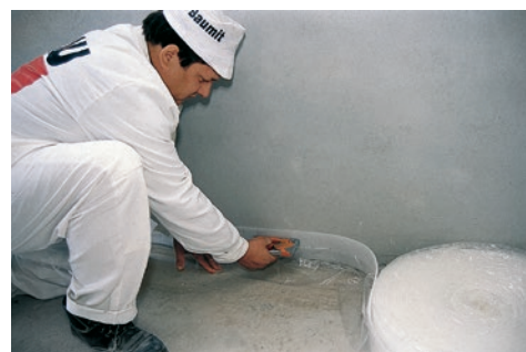
Wykonanie dylatacji obwodowej.
