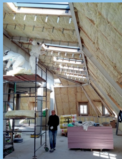
Prace na poddaszu mansardowym zabudowanym płytą ognioodporną. Pracownicy w specjalnych kombinezonach i maskach przeciwpylowych układają wełnę szklaną Isover.
