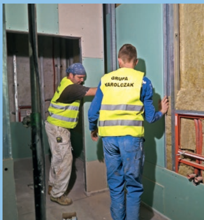
Zabudowa wodoodporną płytą g-k (system Knauf) ścianki instalacyjnej w łazience.
