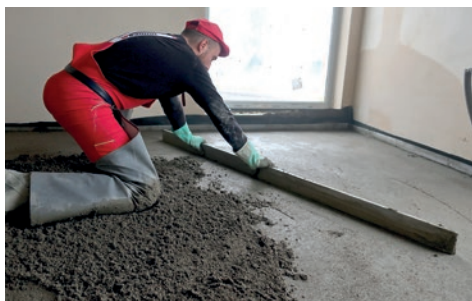
Układanie zaprawy.
