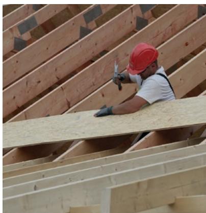
Montaż płyt OSB na konstrukcji dachu.
