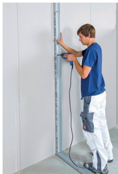
Montaż profili obwodowych CW do sąsiednich ścian.
