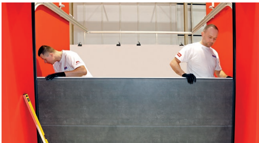
Montaż segmentów
