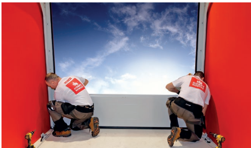
Montaż segmentów
