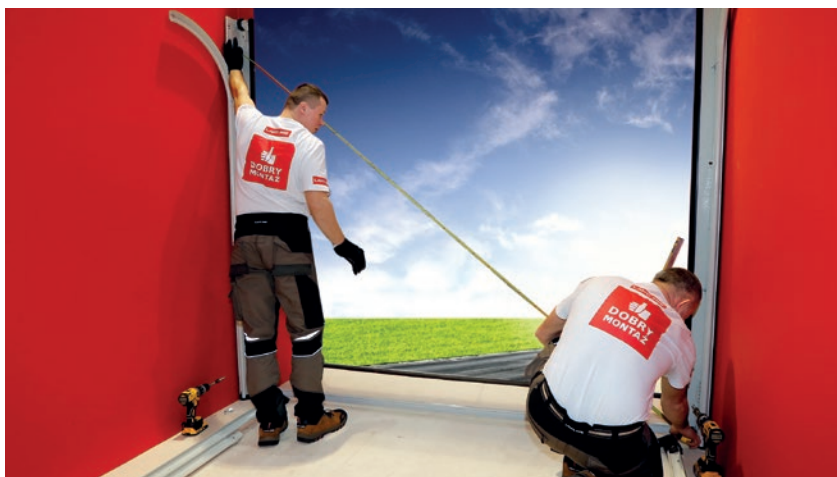
Mierzenie przekątnej przy montażu ościeżnicy
