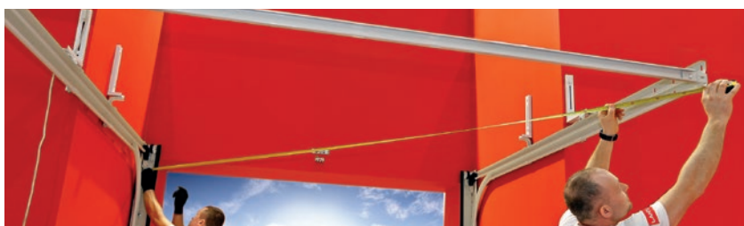
Mierzenie przekątnej przy montażu prowadnic poziomych
