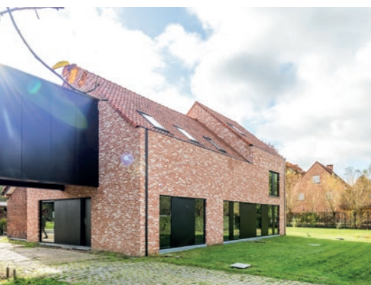
Fot. ach. Sens architecten, Boortmeerbeek
