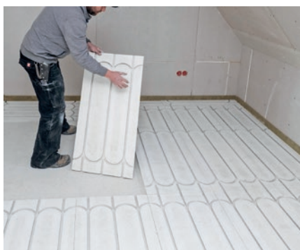
Układanie elementów ogrzewania podłogowego
