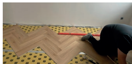
Montaż paneli winylowych ułożonych w jodełkę
