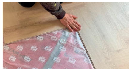
Montaż paneli winylowych z rdzeniem mineralnym bezpośrednio na folii grzewczej
