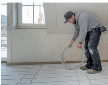
Układanie rur kompozytowych o średnicy 16 mm
