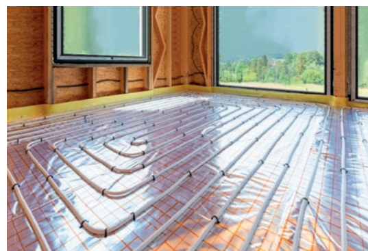
Wodna instalacja podłogowa
