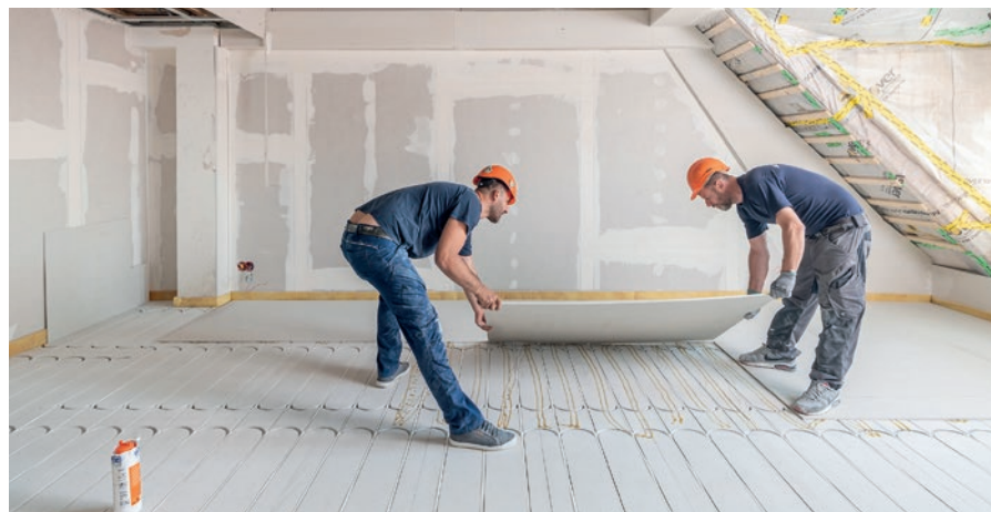
Montaż dodatkowej płyty gipsowo-włóknowej o gr. 10 mm, która jest przyklejana i przykręcana jako przykrycie instalacji ogrzewania podłogowego
