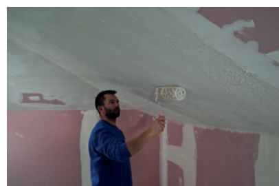
Wykańczanie powierzchni płyt
