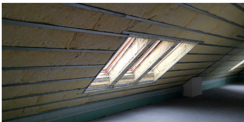
Przykładowe poddasze zaizolowane wełną mineralną szklaną po zamontowaniu drugiej warstwy izolacji (aut. Piotr Ślusarczyk).
