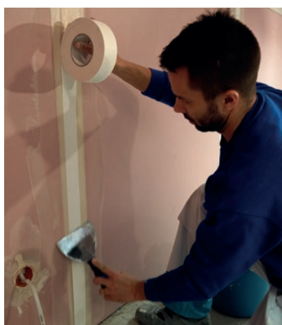
Wtapianie taśmy spoinowej (na połączeniu płyt)
