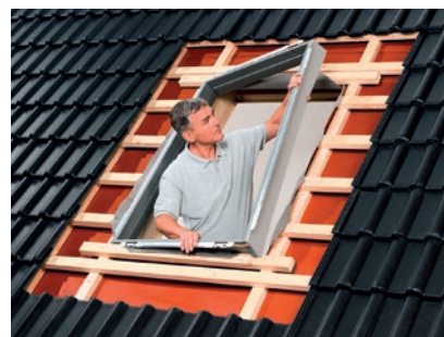
Montaż ramy izolacyjnej BDX wchodzącej w skład systemu ciepłego montażu.
