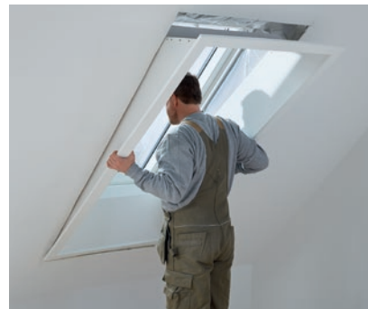
Montaż wewnętrznej wnęki okiennej LSB dopasowanej do rozmiaru okna dachowego i grubości konstrukcji dachu.
