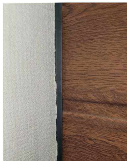
Uszczelnienie w trakcie docieplenia
