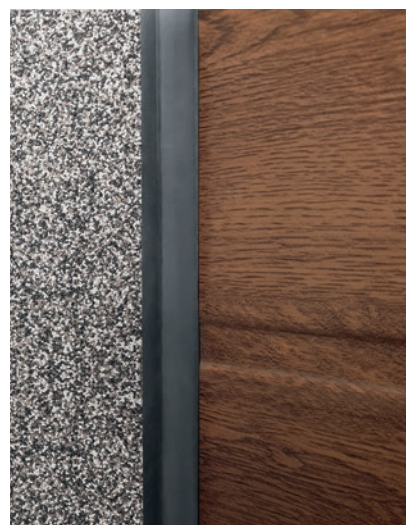
Uszczelnienie po dociepleniu
