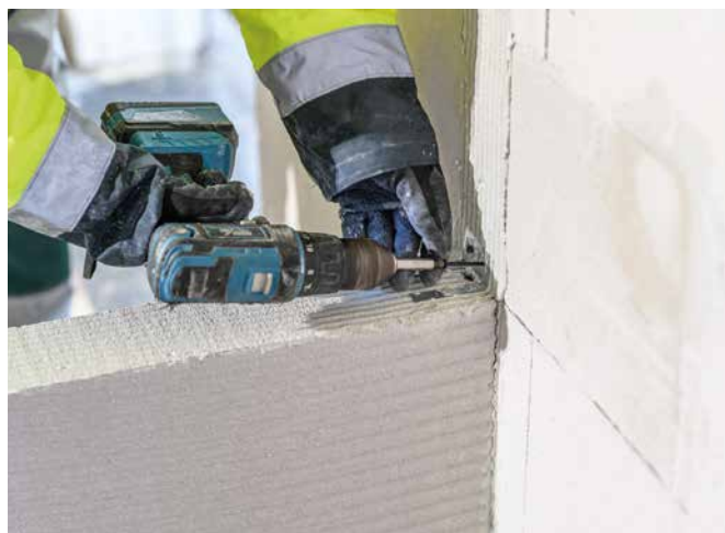
Fot. Montaż łącznika mechanicznego łączącego ścianę działową z betonem komórkowym ze ścianą nośną.
