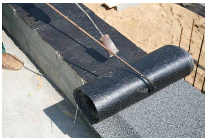
Fot. Zakładanie poziomej izolacji przeciwwilgociowej na ścianach fundamentowych
