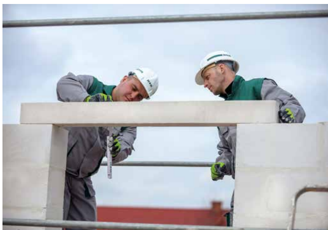
Fot. Osadzenie na ścianie prefabrykowanego, systemowego nadproża ze zbrojonego betonu komórkowego.
