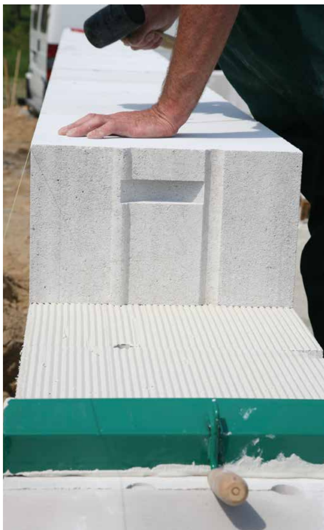
Fot. Prawidłowe nakładanie warstwy zaprawy murarskiej do cienkich spoin za pomocą systemowej kielni.
