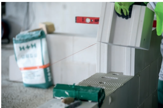
Uchwyty w bloczkach silikatowych ułatwiają prawidłowe ustawienie ich w warstwie muru.
