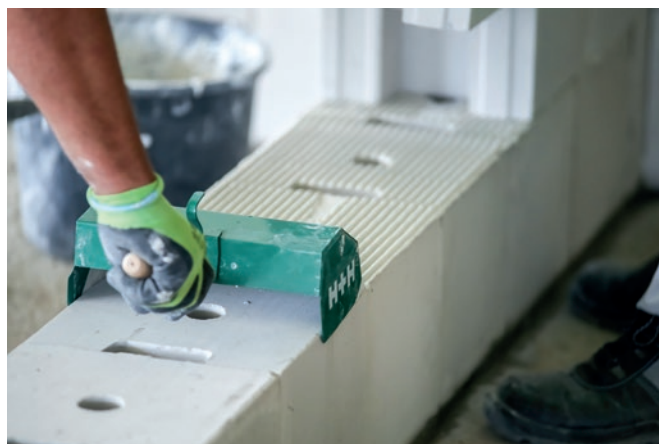
Wysoka dokładność wymiarowa silikatów umożliwia prowadzenie prac murarskich z użyciem zaprawy klejowej.
