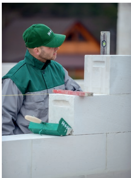
Prowadzenie prac z użyciem betonu komórkowego jest proste i intuicyjne.
