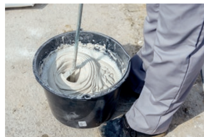
Przygotowywanie zaprawy cienkowarstwowej.
