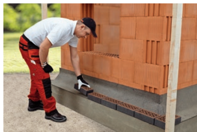
Układanie na sucho pierwszej warstwy.
