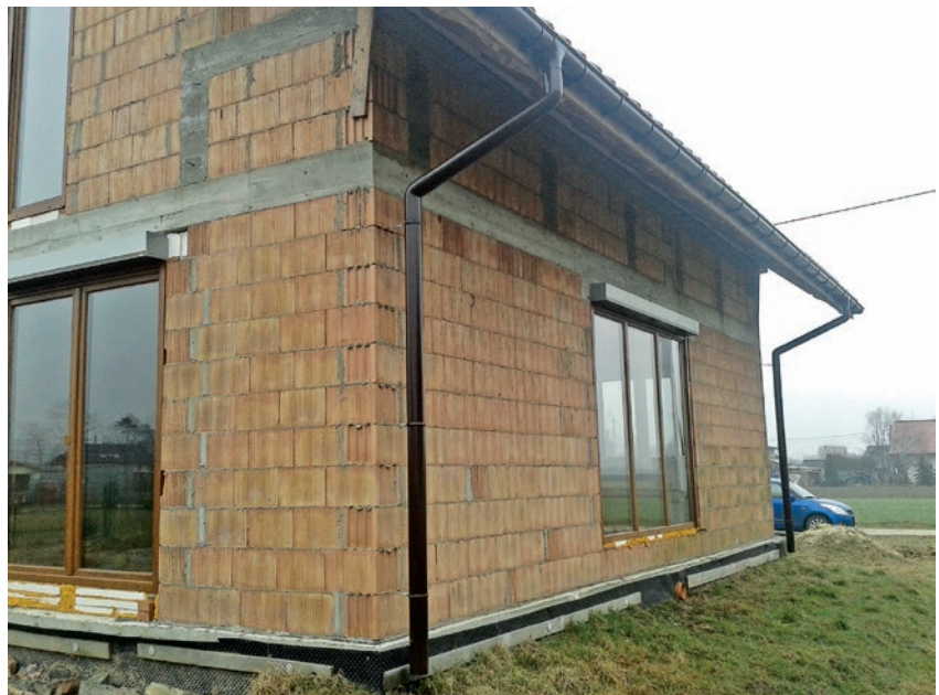
Prawidłowo wykonane naroże ściany z pustaków na pióro i wpust. Widoczne przewiązanie oraz spoina pionowa przyłączeni pustaków w narożu ściany (w miejscu gdzie nie ma zamka na pióro i wpust).
