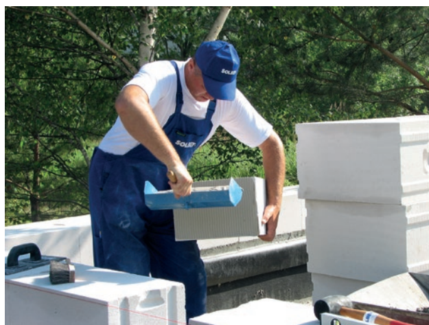
Jeśli murowane bloczki pozbawione są profilowania na pióra i wpusty zaprawą cienkowarstwową należy wypełnić również spoiny pionowe.
