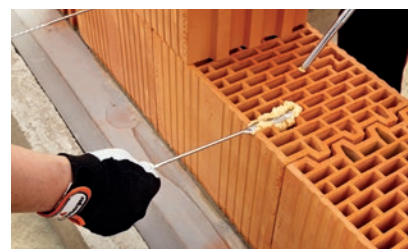
Montowanie kotew w ścianie.
