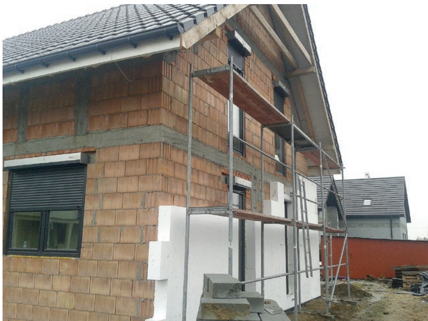
Wykonywanie ściany warstwowej – warstwa konstrukcyjna z ceramiki czerwonej, warstwa izolacyjna ze styropianu.
