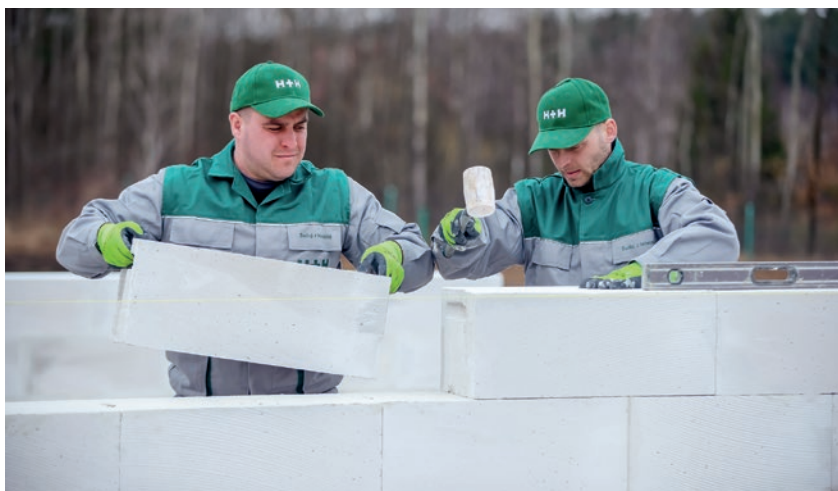
Montaż ściany zewnętrznej z bloczków z betonu komórkowego.
