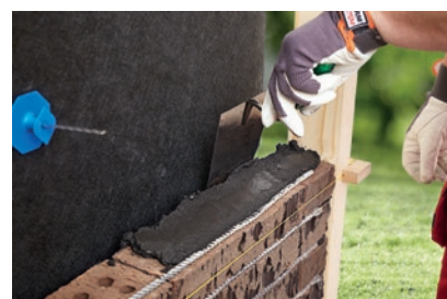
Nakładanie zaprawy na cegły klinkierowe.
