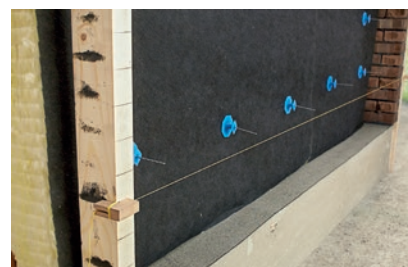
Poziomowanie za pomocą sznurka murarskiego.
