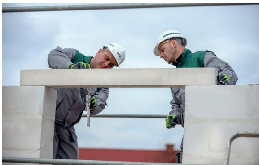
Montaż belki nadprożowej nad otworem okiennym.
