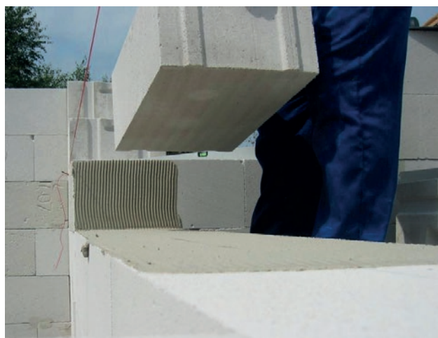
Cienka warstwa zaprawy murarskiej SOLBET 0.1 nie pogarsza parametrów termicznych ścian jednowarstwowych, jak ma to miejsce w przypadku tradycyjnych zapraw nanoszonych warstwą grubości 8–15 mm.
