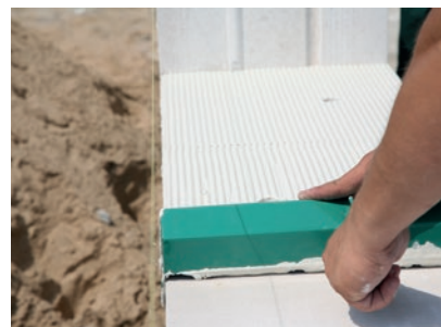
Nakładanie zaprawy cienkowarstwowej o grubości 1 \div 2 \text{ mm} .
