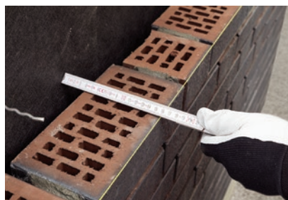
Przykładowa grubość wentylowanej pustki powietrznej.
