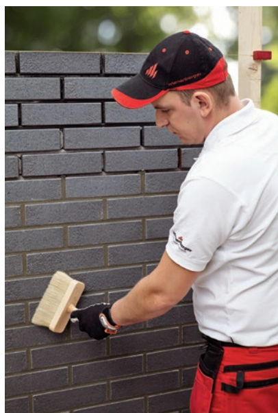
Czyszczenie na sucho muru po zakończeniu prac.
