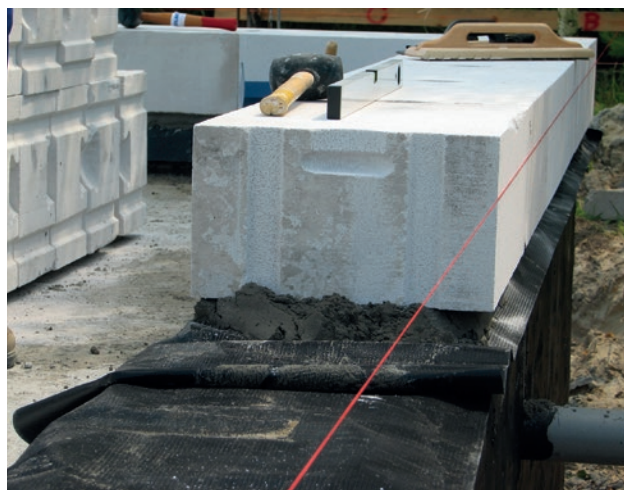
Wysoka dokładność wymiarowa bloczków SOLBET oraz powierzchnie czolowe wyprofilowane na pióra i wpusty ułatwiają prace murarskie i pozwalają uzyskać idealnie równe mury.
