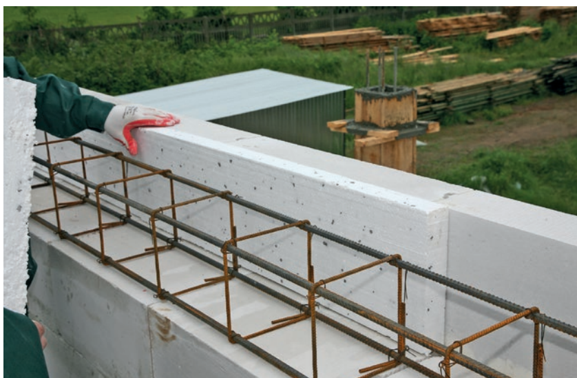
Ocieplanie wienca za pomocą płyt styropianowych.
