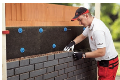
Układanie cegieł klinkierowych.
