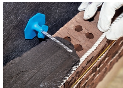
Kotwienie ściany elewacyjnej.
