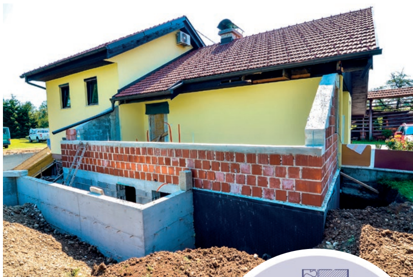
Izolacja ściany fundamentowej płytami XPS
