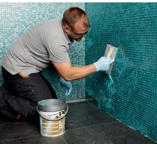
Zastosowanie fugi PCI Durapox® Premium Multicolor do spoinowania mozaiki
