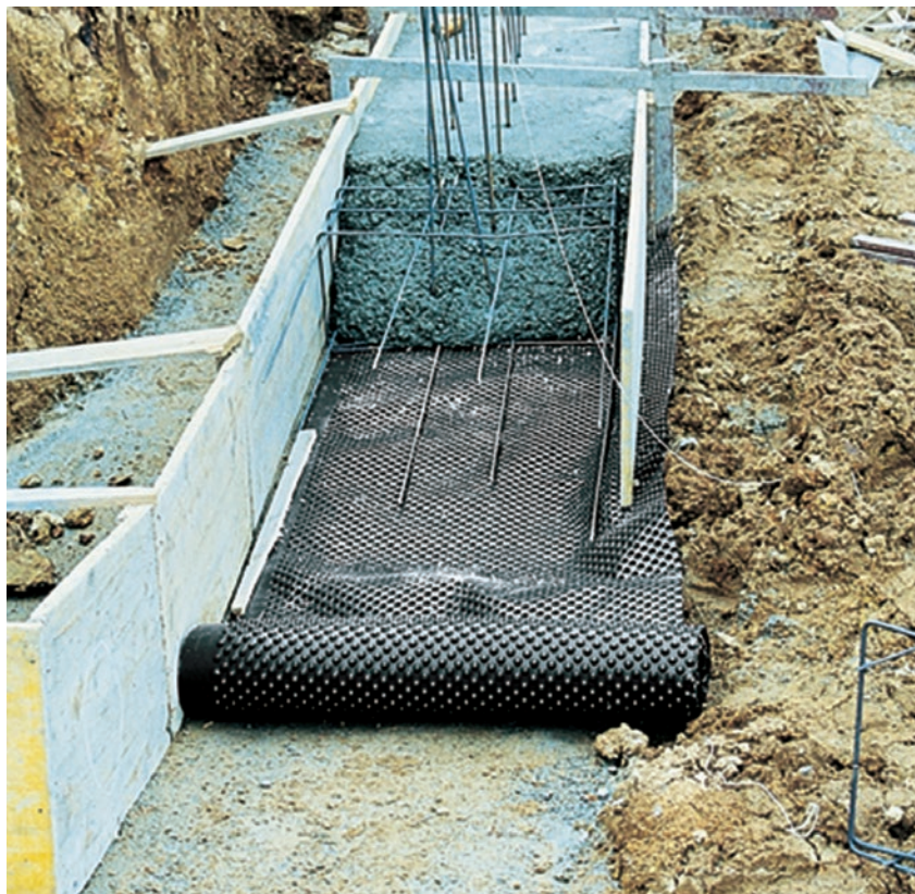
Folia fundamentowa jako izolacja pozioma
