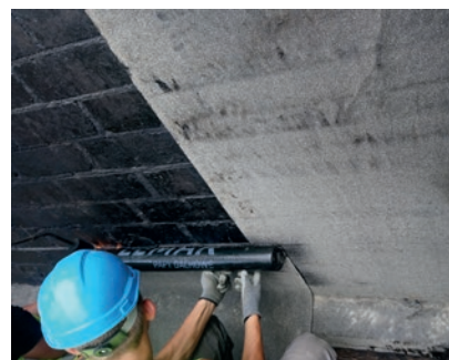
Montaż papy na ścianie fundamentowej budynku
