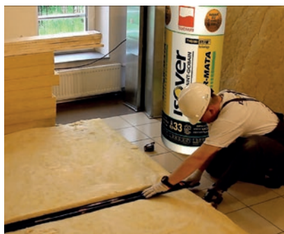
Krok 4: Docinanie wełny w poprzek eliminuje powstawanie odpadów i ścinaków materiału z rolki.
