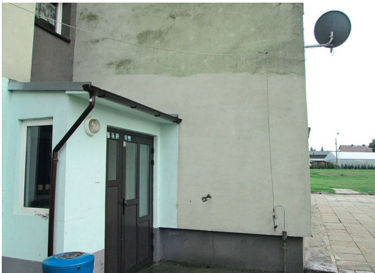
Porównanie przed i po czyszczeniu
