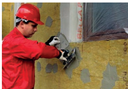
4 Przyklejanie siatki z włókna szklanego przy otworach okiennych i drzwiowych.
