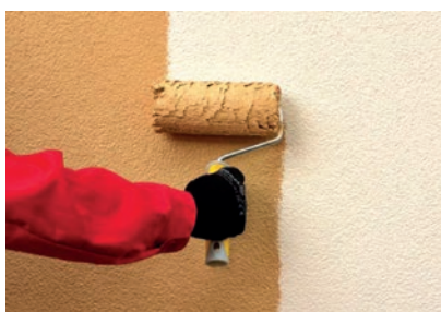
11 Malowanie tynku farbami elewacyjnymi.
