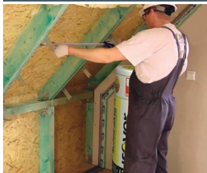
Krok 1: Pomiar rozstawu krokwi – podczas cięcia wełny należy doliczyć naddatek około 2 cm.
