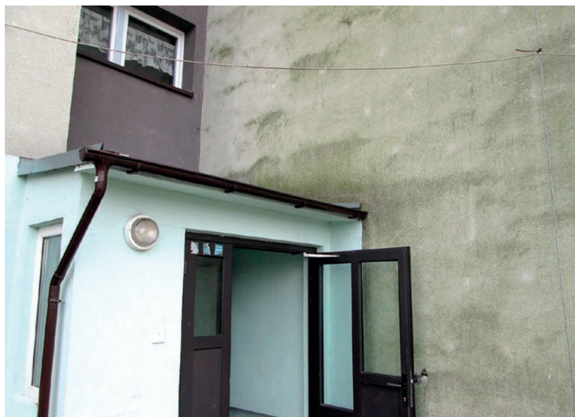
Przykład agresji mikrobiologicznej na ścianie
