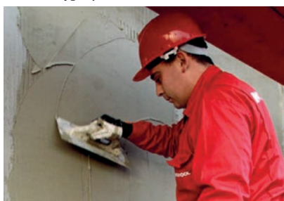
8 Wygładzenie powierzchni zatapiającej siatki.
