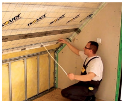
Krok 10: Montaż taśmy montażowej pod następnym arkuszem paroizolacji.
