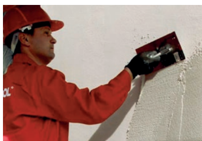
10 Wykonanie tynku zewnętrznego.
