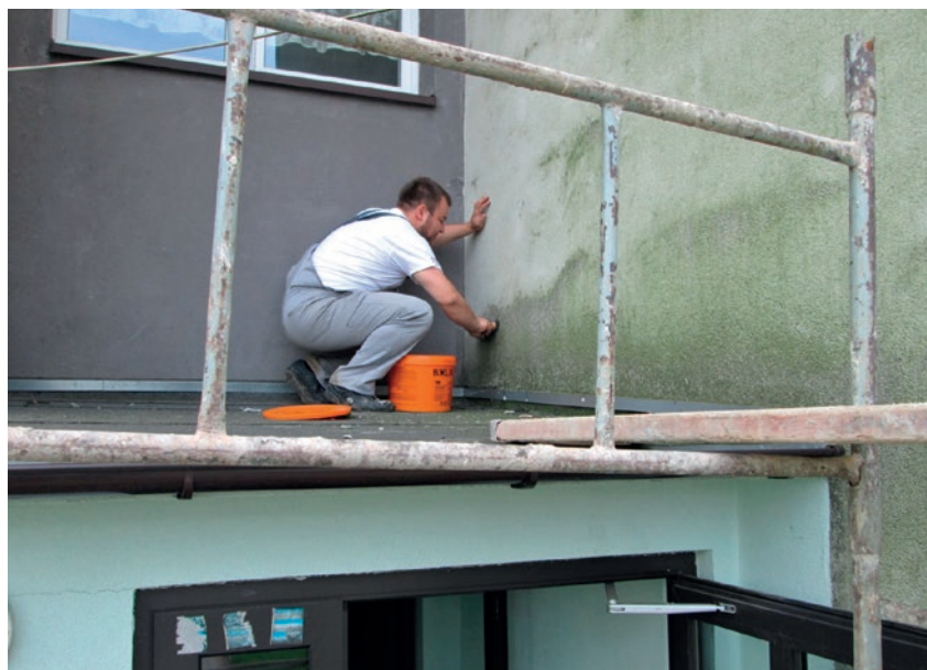
Usuwanie skażenia przy użyciu BOLIX GLO COMPLEX
