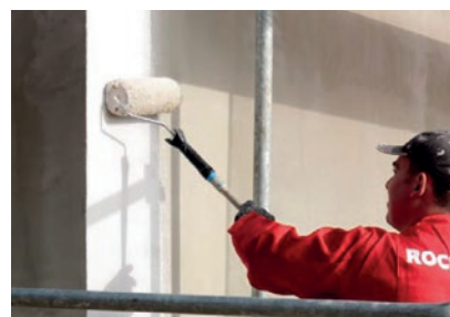
9 Nałożenie podkładu tynkarskiego.
