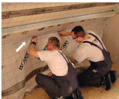
Krok 11: W celu swobodnej pracy konstrukcji należy przewidzieć naddatek folii paroizolacyjnej 1–2 cm – brak szkodliwych naprężeń.
