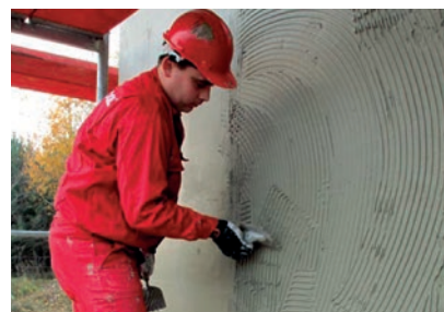
6 Nałożenie zaprawy zbrojącej za pomocą pacy zębatej.
