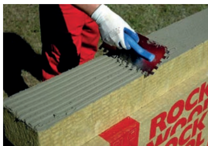
1 Naniesienie zaprawy klejącej na płytę.
