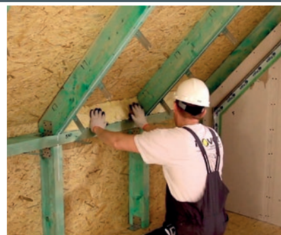
Krok 3: Szczelne zaizolowanie murlaty w celu zapewnienia ciągłości izolacji. Docięcie wełny w zależności od kąta nachylenia dachu.
