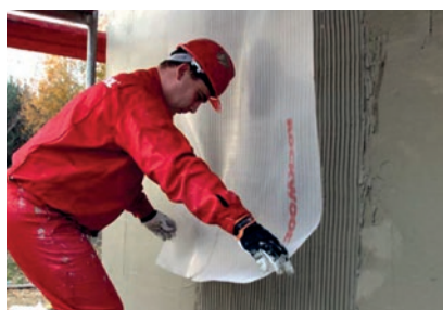
7 Wtopienie siatki z włókna szklanego.
