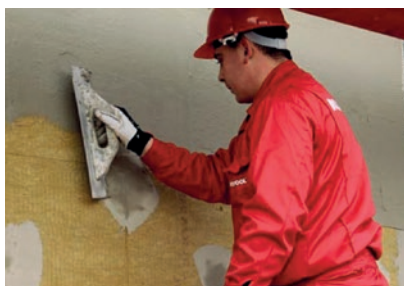
5 Gruntowanie powierzchni skalnej wełny cienką warstwą zaprawy zbrojącej gładką stroną pacy.
