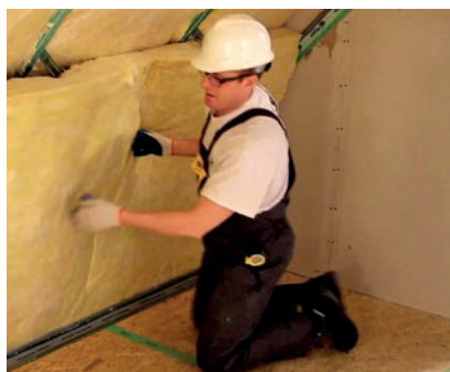
Krok 7: Montaż drugiej warstwy wełny.
