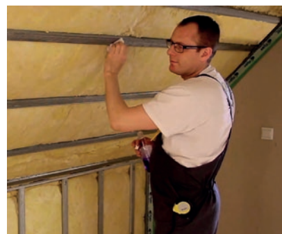
Krok 9: Odtłuszczenie profili i przyklejenie taśmy montażowej do zamocowania inteligentnej aktywnej paroizolacji.
