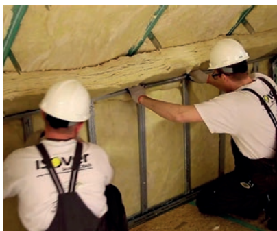
Krok 8: Zapięcie rusztu pod okładzinę.
