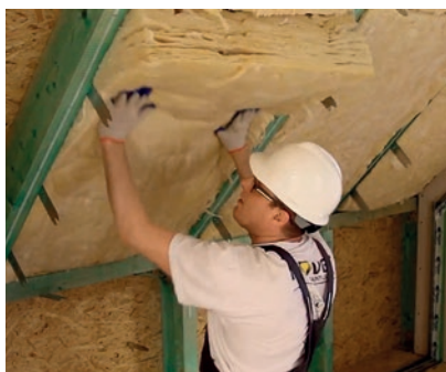
Krok 5: Izolacja pierwszej warstwy między krokwiami. Najczęściej jest to 15 lub 20 cm produktów o niskich lambdach np. 0,032 W/mK.
