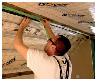
Krok 12: Zapewnienie szczelności powłoki paroizolacyjnej.
