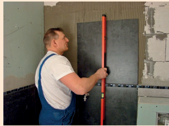
Poziomowanie przyklejanej płytki ceramicznej Cersanit.
