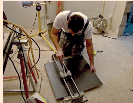
Przycinanie płytki gilotyną ręczną.
