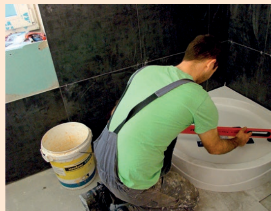
Przymiar brodzika pod kabiną prysznicową.
