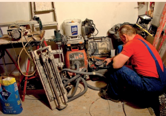
Robert Aksamitowski porządkuje zaplecze remontu łazienki.
