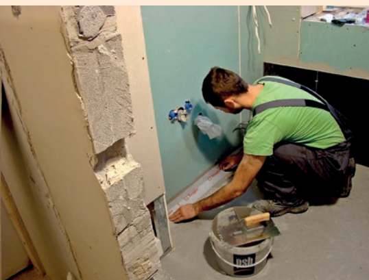
Hydroizolacja narożnika taśmą.
