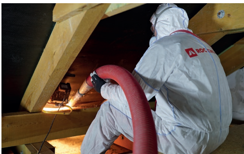
Nadmuchiwanie izolacji z granulatu skalnego GRANROCK SUPER.
