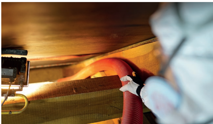
Nadmuchiwanie izolacji najlepiej rozpoczynać od skrajnych punktów budynku, np. naroży.
