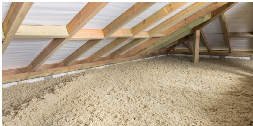
Prawidłowe wykonanie nadmuchu izolacji poziomej przestrzeni poddasza nieużytkowego.
