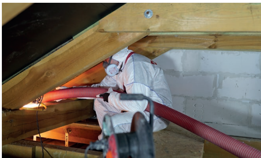
Przy wykonywaniu nadmuchu na dachach więzów wykorzystuje się wcześniej przygotowane podesty umożliwiające poruszanie się po przestrzeni poddasza i aplikację granulatu.
