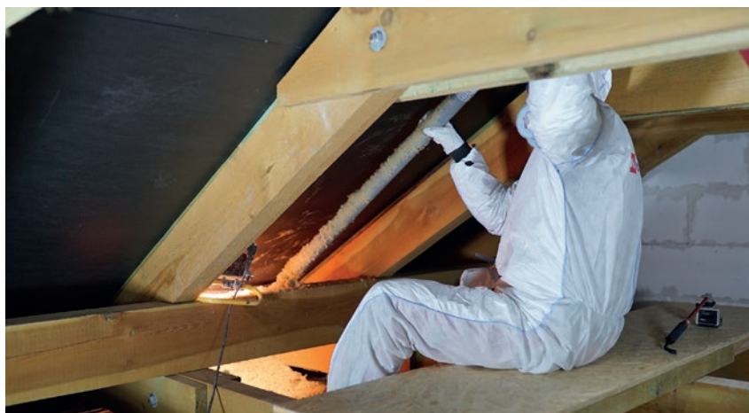
Izolowanie murlaty przy pomocy lancy przedłużającej, ułatwiającej dostęp do trudno dostępnych miejsc.
