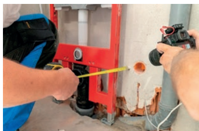
Montaż stelaża WC
