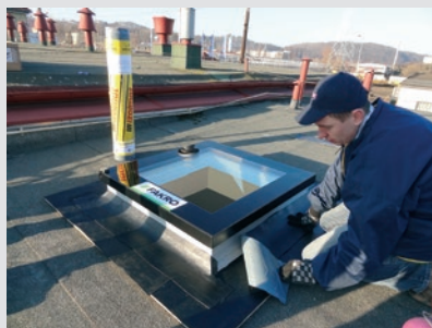
6 Instalacja wycinków papy samoprzylepnej podkładowej na styku powierzchni poziomej i pionowej kołnierza okna na wysokości połowy ramy okiennej, obwodowo.
