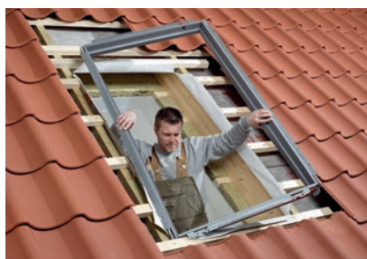
Rama izolacyjna do montażu okna dachowego.
