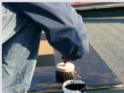
1 Gruntowanie podłoża.
