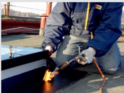
5 Specjalna obróbka stref krawędziowych.
