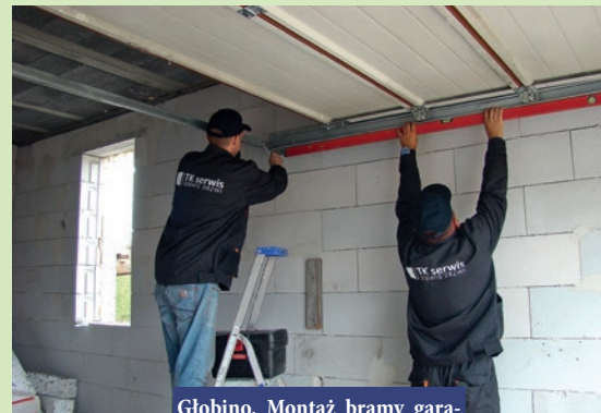
Głębino. Montaż bramy garażowej wymaga dużej precyzji.
