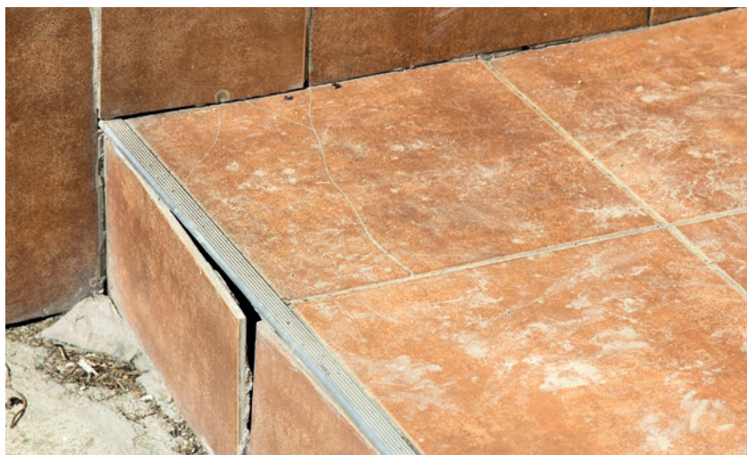
Odpadające płytki
