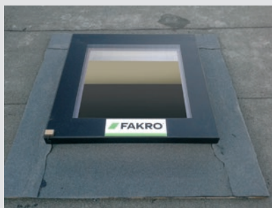
9 Prawidłowo wykonany montaż i obróbka uszczelniająca okna do dachów płaskich przy pomocy pap samoprzylepnych.
