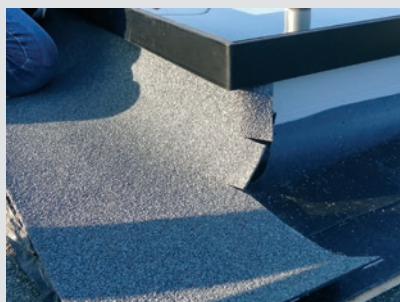
7 Instalacja samoprzylepnej papy wierzchniej go krycia na ramie okna w części poziomej i pionowej.
