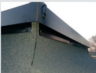
8 Montaż listew dociskowych na górnej pionowej krawędzi papy wierzchniego krycia.
