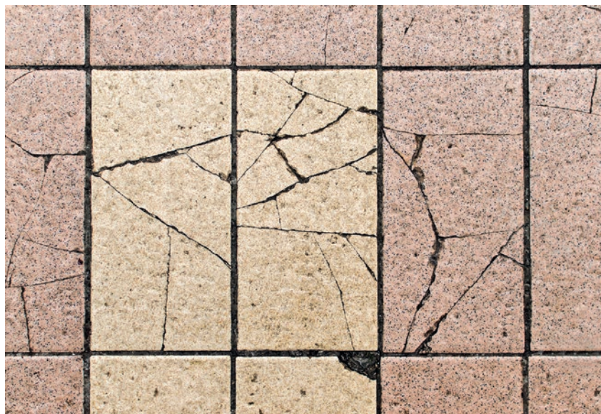
Pękające płytki
