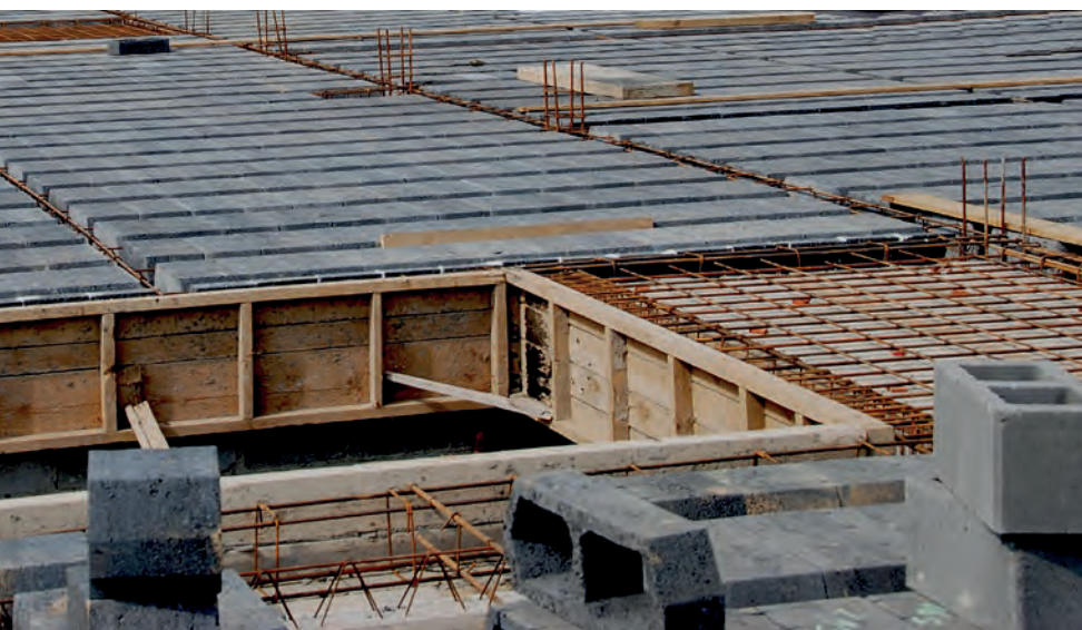
Strop przed betonowaniem.
