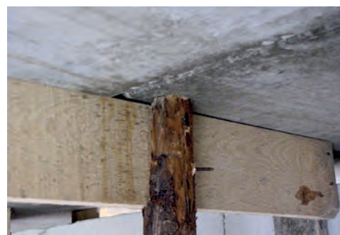
↑ Niewłaściwe wykonanie podparcia montażowego, oparcie płyty na stemple montażowym powoduje nierówności dolnej powierzchni stropu, a nawet może doprowadzić do uszkodzenia (zarysowania) płyty w trakcie montażu.
