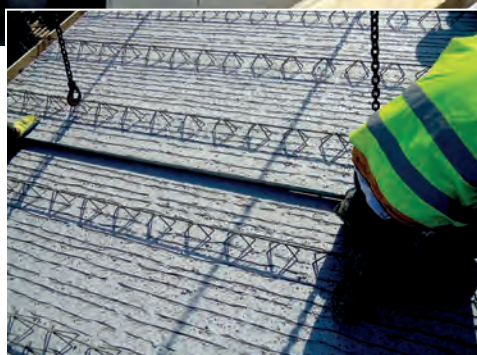
↑ Prawidłowe zaczepienie haków w węzłach krzyżulców dźwigarów kratowych.
