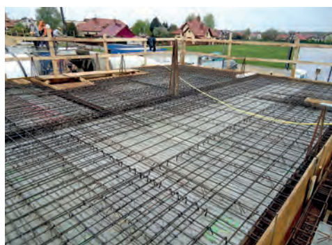
↑ Zbrojenie w nadbetonie (zbrojenie układane na płytach i zbrojenie górne).
