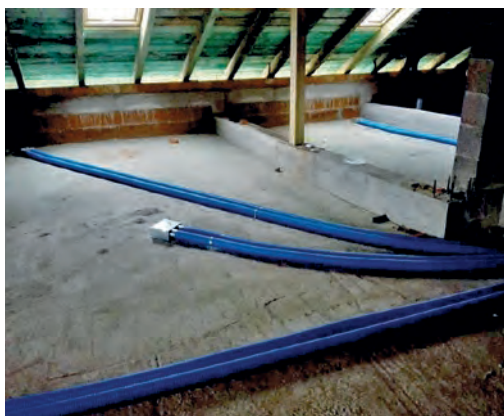
Montaż kanałów elastycznych DN 75 w stropie.
