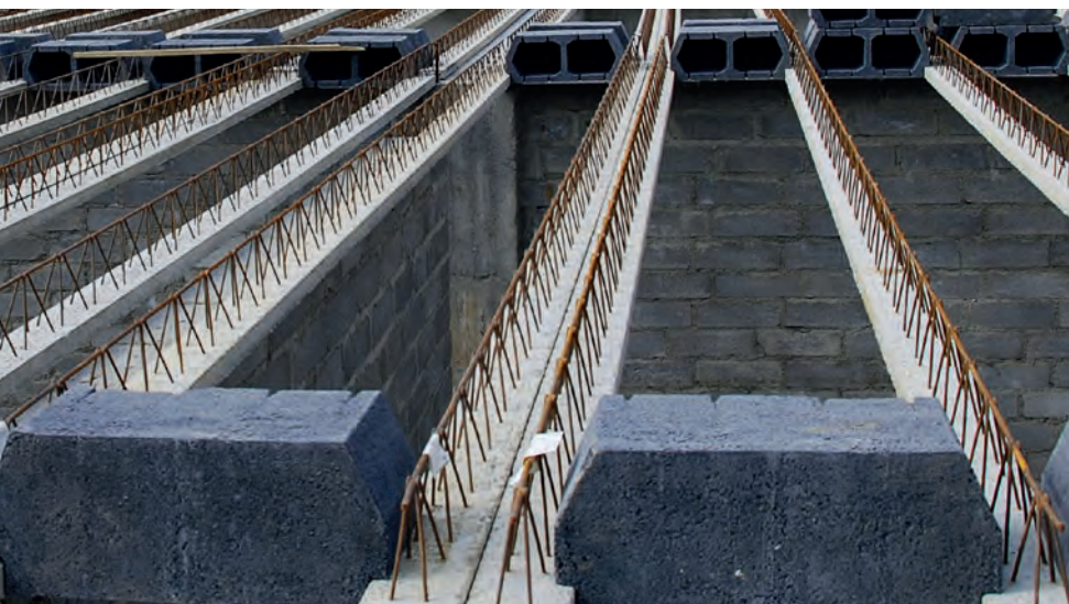
Układanie elementów stropu.
