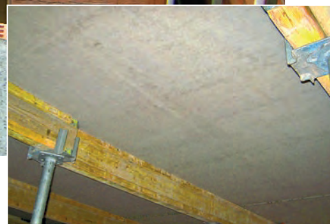
↑ Gładka powierzchnia płyt stropowych nie wymaga tynkowania.
