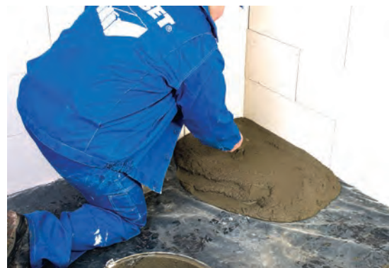
Rozrobioną zaprawę wylewa się na przygotowane odpowiednio podłoże, tak jak tradycyjne jastrychy cementowe.
