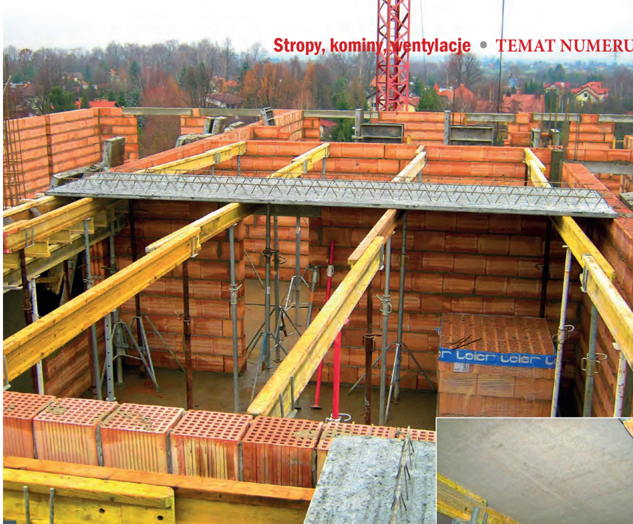
↑ Podparcie montażowe stropów typu Filigran.
