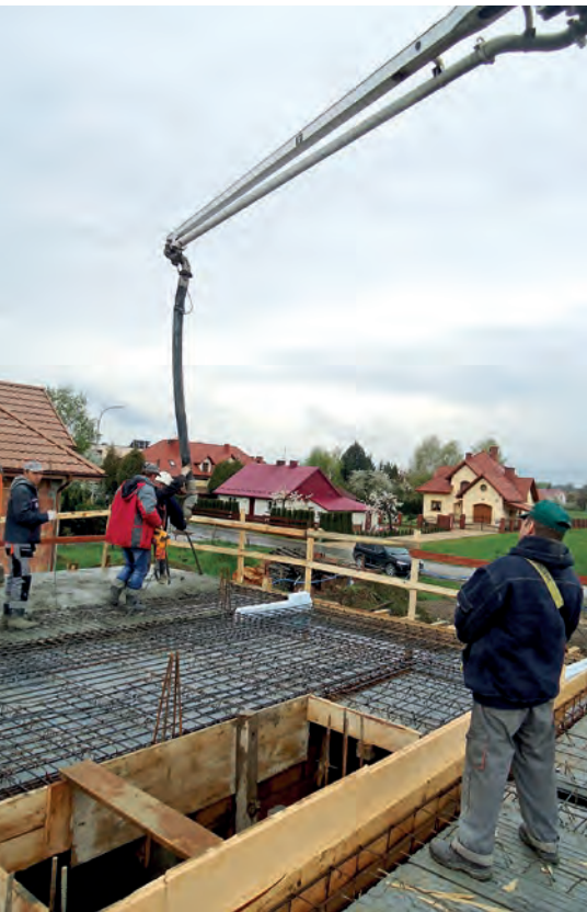
↑ Etap betonowania stropu.
