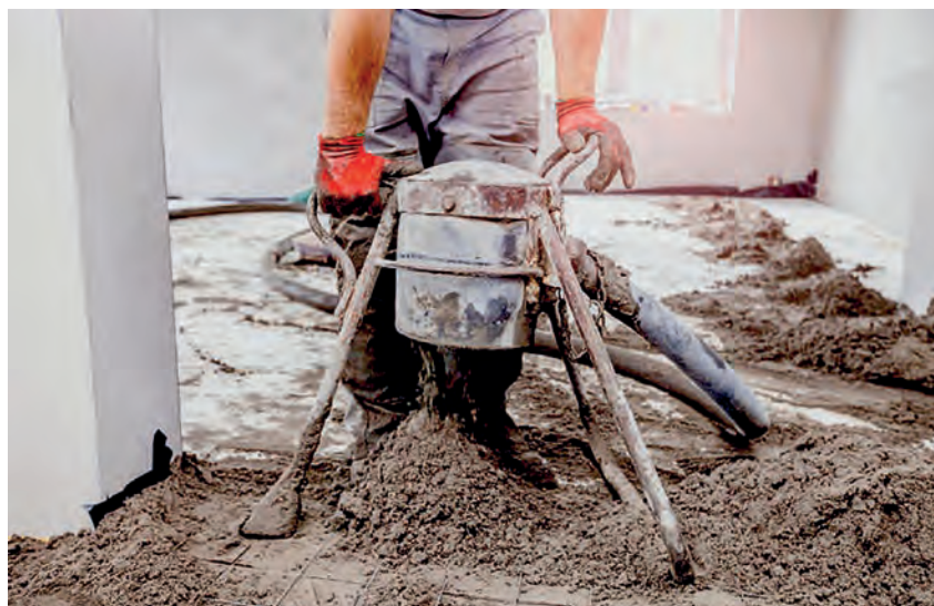
Posadzka cementowa 8.1 SOLBET oraz Betonit B25 8.6 SOLBET to produkty, które mogą być układane mechanicznie za pomocą mixokreta.
