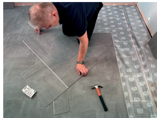
To już ostatni etap – instalacja paneli winylowych z rdzeniem mineralnym na gotowym systemie.
