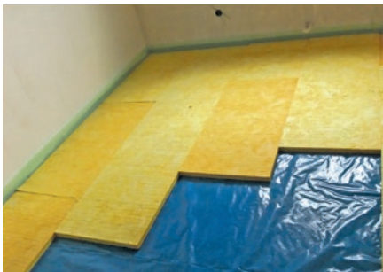
❶ Układanie izolacji termicznej/akustycznej.
