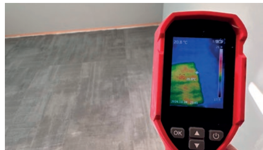
Kontrola systemu ogrzewania.
