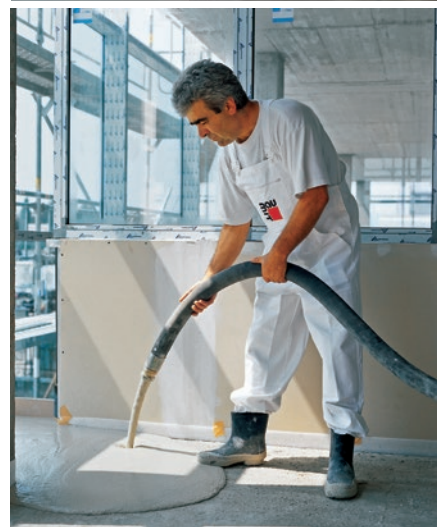
● Porównanie układanie jastrychu vs układanie masy samopoziomującej.
