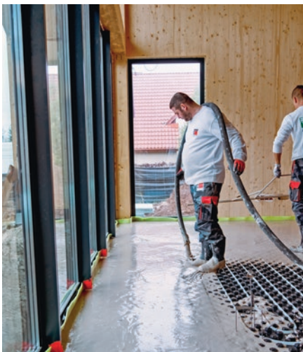
❷ Układanie podkładu samopoziomującego na ogrzewaniu.
