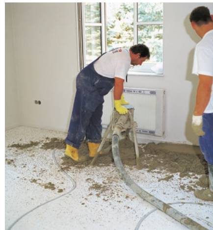
❸ Układanie maszynowego jastrychu cementowego.
