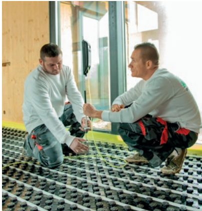
Niwelacja podłoża – ustalanie poziomu znaczników wysokości – tzw. reperów.
