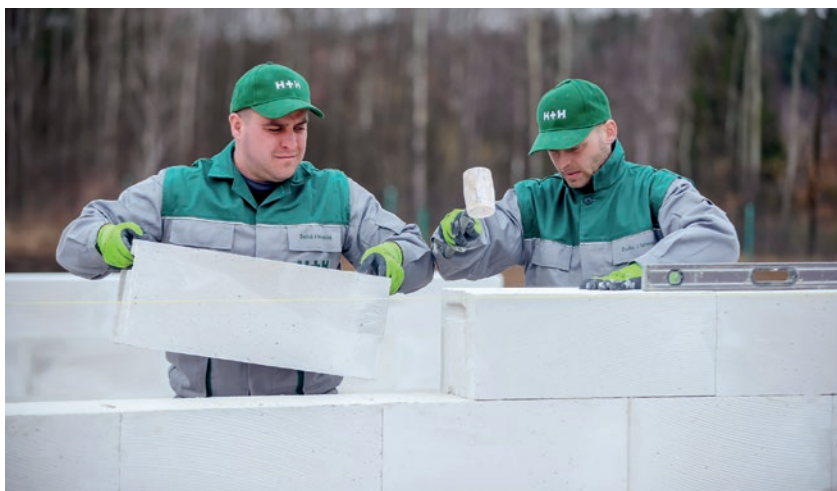
Murowanie przegród z betonu komórkowego w dwuosobowych zespołach przebiega sprawnie.
