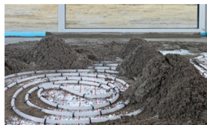
Układanie jastrychu cementowego (konsystencja pólucha) na rurkach ogrzewania wodnego.
