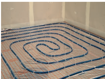
Izolacja podłogi z ogrzewaniem podłogowym.
