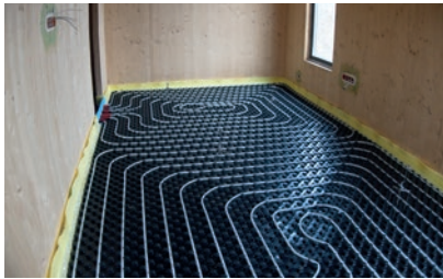
Ułożona taśma dylatacyjna oraz rurki ogrzewania wodnego na systemowej płycie z wypustkami.
