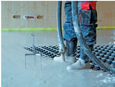
Układanie samopoziomującego podkładu Alpha na ogrzewaniu podłogowym.
