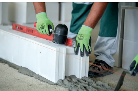
Poprawne wykonanie pierwszej warstwy jest istotne dla jakości wykonania całej przegrody.
