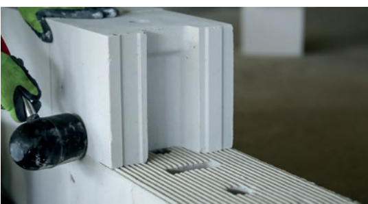
Ustawienie kolejnych bloczków w warstwie można korygować przy użyciu gumowego młotka.
