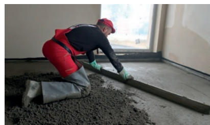
Rozprowadzanie jastrychu cementowego metalową łatą.
