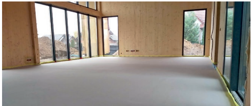
Powierzchnia podkładu samopoziomującego gotowa do układania warstw wykończeniowych.
