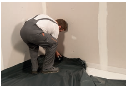
Rozkładanie pierwszej warstwy izolacji.
