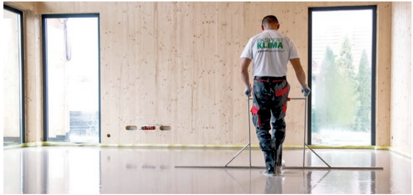
Finalna obróbka podkładu samopoziomującego za pomocą tzw. „sztangi”.
