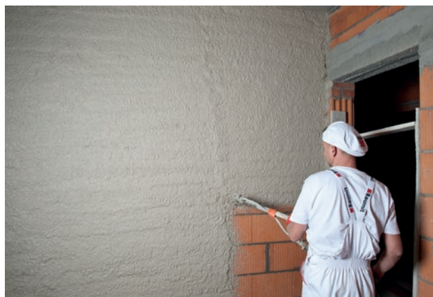
Układanie maszynowe tynku Baumit KlimaWhite
