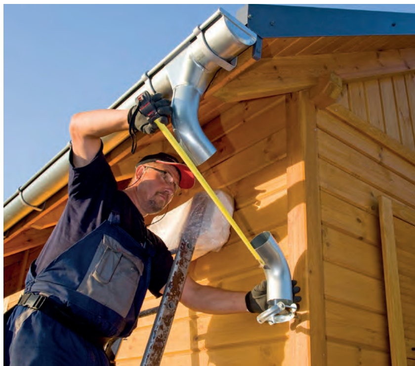
Wymierzenie długości łącznika pomiędzy kolankami.
