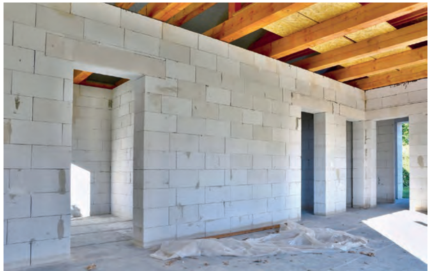
Z betonu komórkowego muruje się ściany zewnętrzne oraz przegrody wewnątrz budynku. Porowata struktura sprawia, że materiał ten jest w stanie przyjąć nadmiar wilgoci z pomieszczenia oraz oddać ją, gdy powietrze stanie się zbyt suche.
