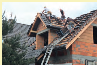
Dom w Czerwionce, pow. rybnicki. Przykręcanie dachówek bocznych i transport dachówki windą dekarzką.
