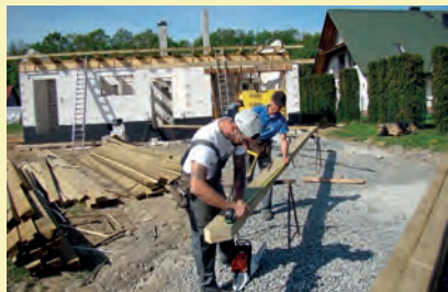
Prace przy więźbie dachowej domu jednorodzinnego w Grodzcu na Śląsku Cieszyńskim.
