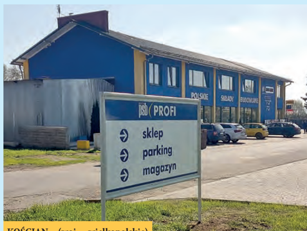
KOŚCIAN (woj. wielkopolskie) – placówka Profi należy do firmy MAG-MIR – powierzchnia obiektu 700 mkw., magazynu 500 mkw., placu składowego 7000 mkw.
