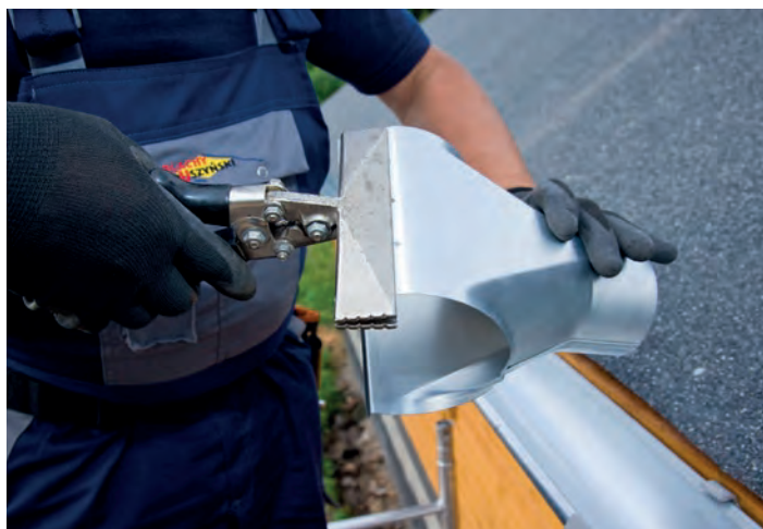
Przygotowanie sztucera do montażu w rynnie.
