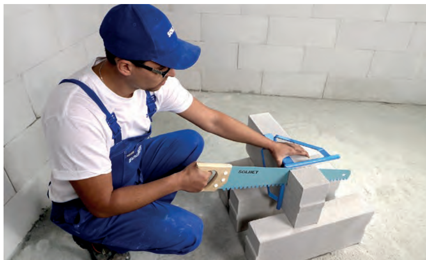
Docinianie bloczków na żądany wymiar ułatwia użycie prowadnicy kątowej. Po docięciu elementy murowe wymagają jedynie przeszlifowania i odpylenia przed murowaniem.
