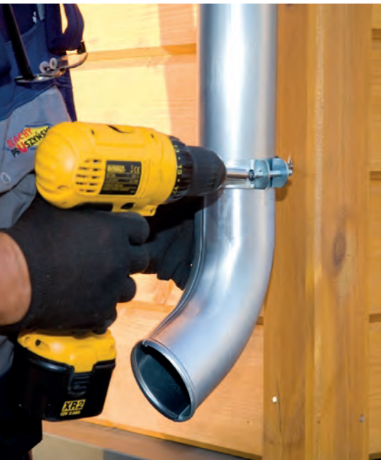
Montaż obejm y rury spustowej.
