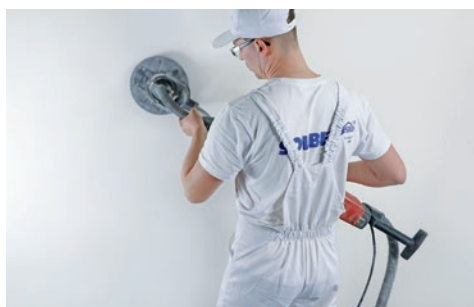
Dzięki zastosowaniu tzw. żyrafy szlifowanie powierzchni przebiega szybko i sprawnie, a pylenie jest mocno ograniczone.
