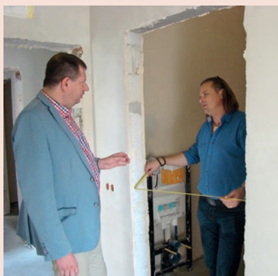
Spotkanie z inwestorem w rozbudowywanym obiekcie – hotel Topaz w centrum Poznania.
