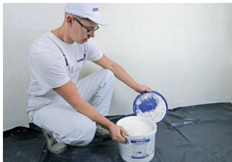
Gotową gładź polimerową przed użyciem zaleca się wymieszać wolnoobrotową wiertarką z mieszadłem koszykowym (mieszadłem do gipsu).
