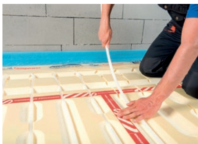
Układanie rury PERT/EVOH/PER w panelu izolacyjnym XPS.
