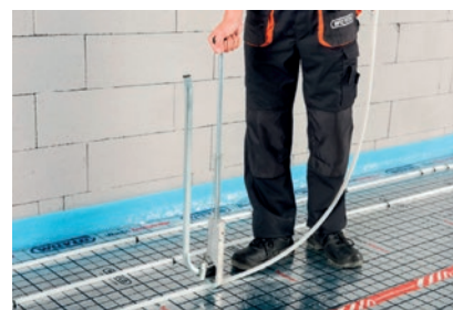
Montowanie rury PERT/EVOH/PERT do płyty styropianowej tacker z folią z nadrukiem przy użyciu tackera.
