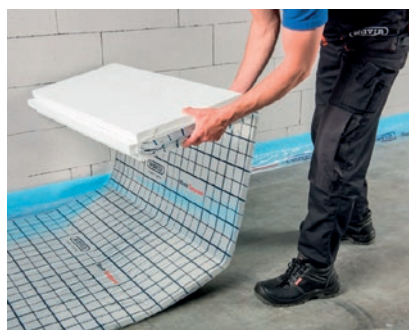
Układanie izolacji.
