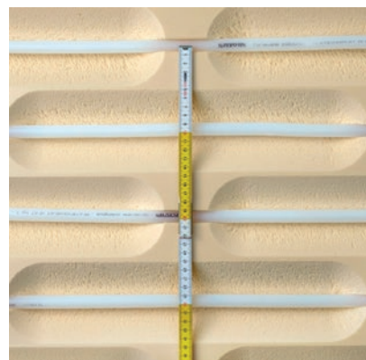
Ułożenie rury PERT/EVOH/PERT w panelu izolacyjnym XPS, w rozstawie co 10 cm.
