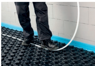
Montowanie rury PERT/EVOH/PERT w panelu systemowym wciskany, położonym na styropianie.
