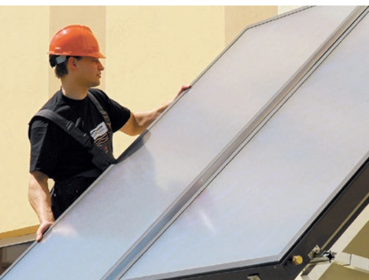
Instalacja solarna do ogrzewania wody użytkowej i wspomagania ogrzewania budynku.
