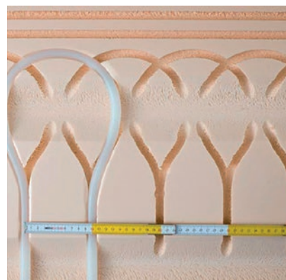
Ułożenie rury PERT/EVOH/PERT w żłobieniach panela izolacyjnego XPS na zakończeniach pętli, na zmianie kierunku rury.
