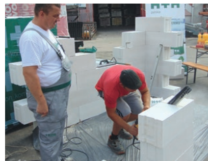
Tomasz Bentkofski i Radosław Dziubak (tnięcie bloczek H+H piłą typu aligator)
