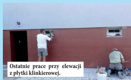
Ekipa Deka-Bud na elewacji. Wykończenia to praca zespołowa.
