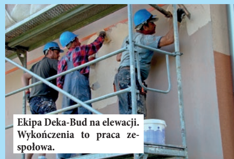
System Atlas. Materiały dostarczyło PSB Profi. Wykonawca docieplenia elewacji – Deka-Bud.
