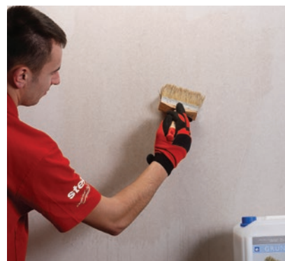
2. Gruntowanie podłoża
