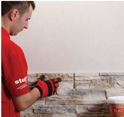
5. Klejenie płytek
