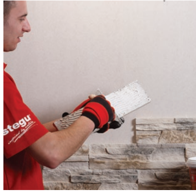
4. Nakładanie kleju
