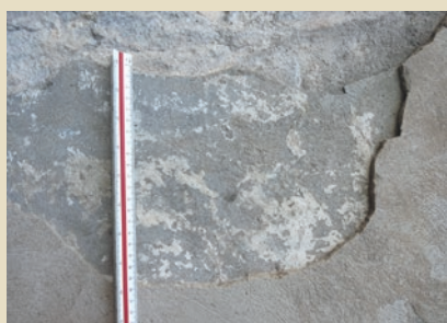
W obiekcie zabytkowym uszkodzone warstwy trzeba dokładnie pomierzyć.
