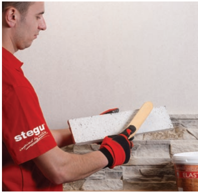
3. Czyszczenie płytek
