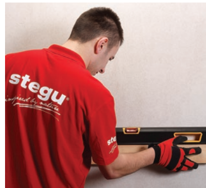
1. Wyznaczanie poziomu ścian
