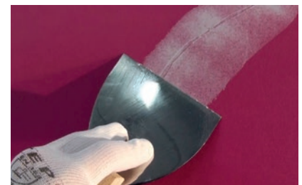
Naprawa rys
