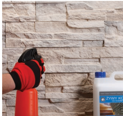
6. Impregnacja płytek
