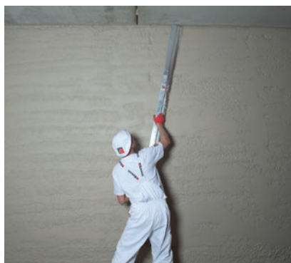
Zaciąganie tynku łątą.
