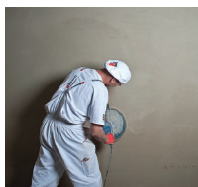
Zacieranie końcowe powierzchni tynku za pomocą zacieraczki mechanicznej.
