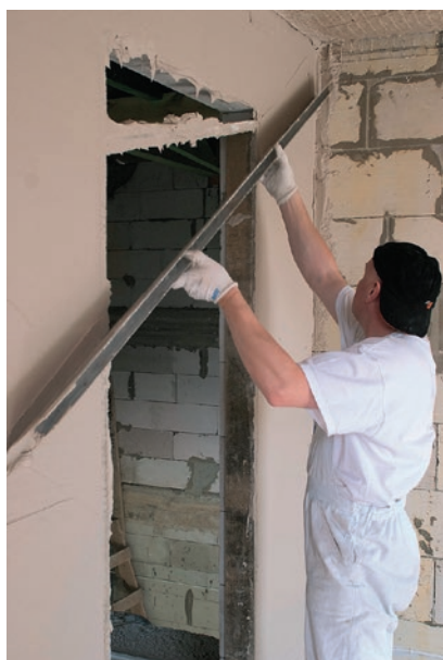
Zaciąganie tynku przy otworze drzwiowym.
