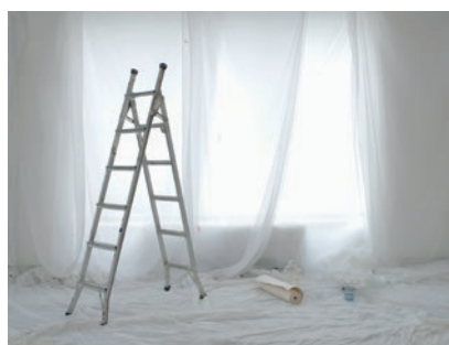
Zabezpieczanie pomieszczenia folią malarską.
