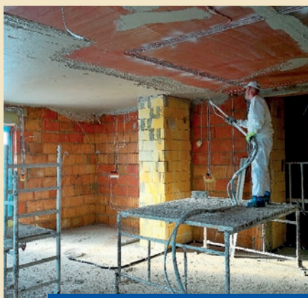
Praca tynkarza jest brudna i ciężka. Pracownicy firmy Tynki Przybylscy w domu jednorodzinnym w Wągrowcu.
