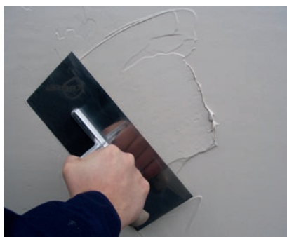
Nakładanie gładzi gotowej pacą stalową.
