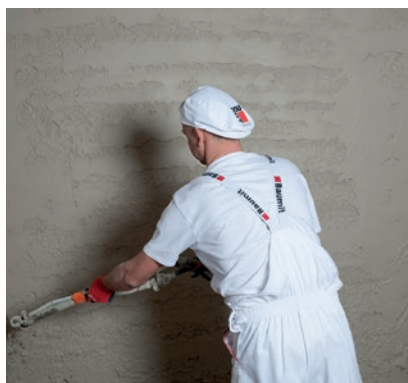
Nakładanie tynku maszynowo.
