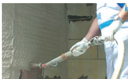
Nakładanie tynku maszynowego.
