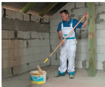
Gruntownie ścian z betonu komórkowego.
