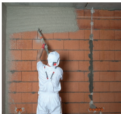
Nakładanie tynku maszynowo.
