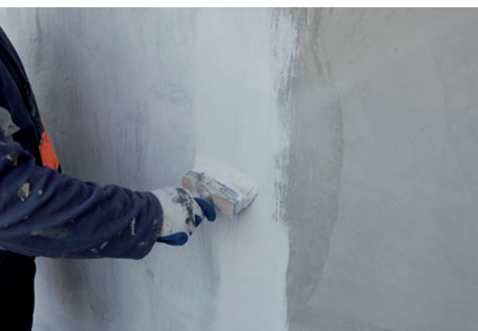
Gruntowanie gruntem szczepnym
