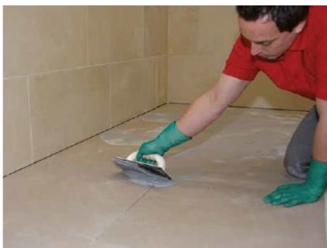
5 Ułożoną powierzchnię z gresu zafugować zaprawą Sopro (np. Sopro DF 10®).
