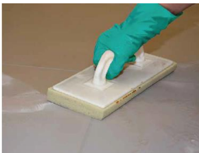
6 Okładzinę zmyć po odpowiednim czasie wiązania zaprawy fugowej Sopro (fuga tężeje w szczelinie spoinowej).
