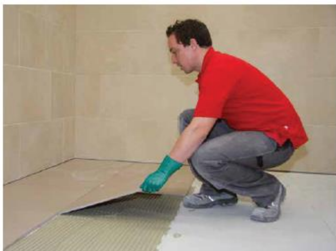
3 Wielkoformatowy gres ułożyć na warstwie grzebieniowej, docisnąć i ustawić w ostatecznym położeniu. Siatkę spoin oczyścić przed związaniem zaprawy klejowej.
