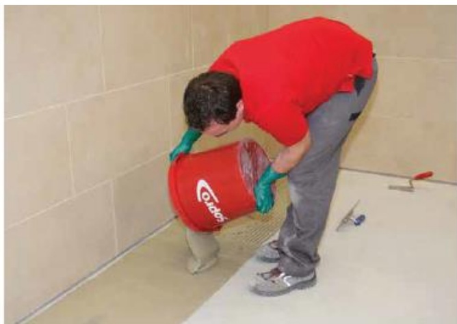
1 Sopro FKM XL o konsystencji półpłynnej wylać na przygotowaną warstwę kontaktową zaprawy klejowej.
