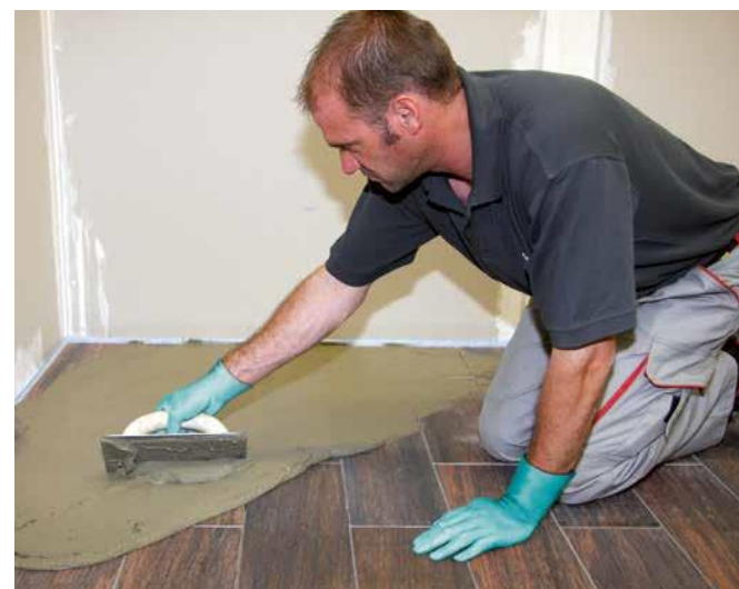
17 Fugowanie płytek fugą elastyczną np. Sopro DF 10®.
