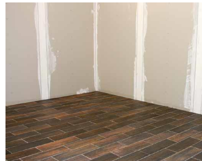
18 Gotowa okładzina ceramiczna na drewnianym podłożu.
