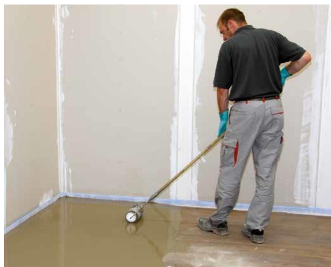
8 Masę szpachlową Sopro FLOOR WS 3.70 extreme rozprowadzić i odpowietrzyć przy pomocy walca z kolcami, aby uzyskać równą powierzchnię podłoża.
