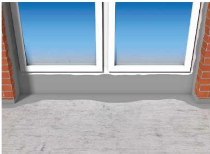
5 Uszczelnianie szczelin przy ościeżnicach okiennych i drzwiowych
