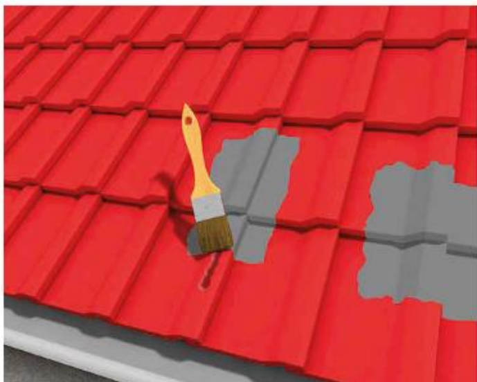
1 Uszczelnianie pokryć dachowych (m. in. dachówek)
