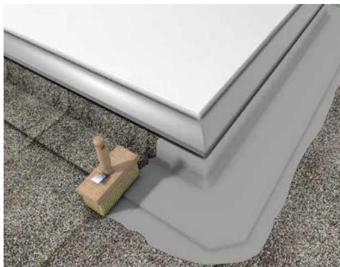
4 Uszczelnianie złączy i nieszczelności wokół włazów, świetlików itp. na powierzchni dachów
