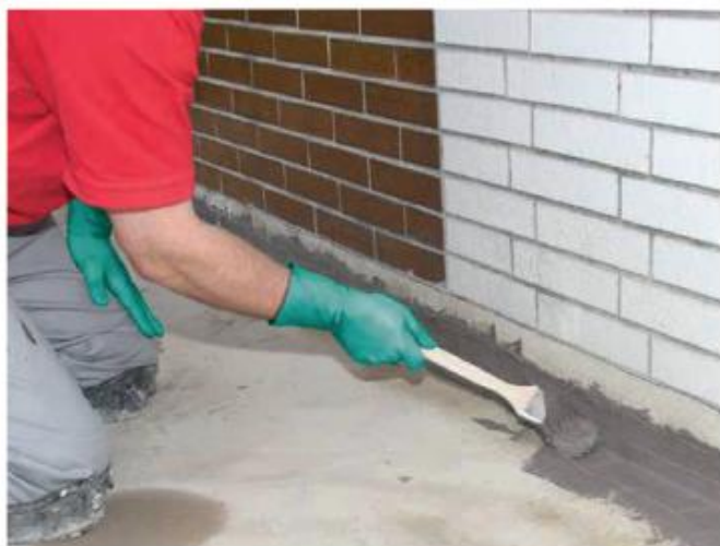
7 W obszarze cokołu, przy pomocy pędzla, nanieść zaprawę Sopro TDS 823 do wklejenia ...
