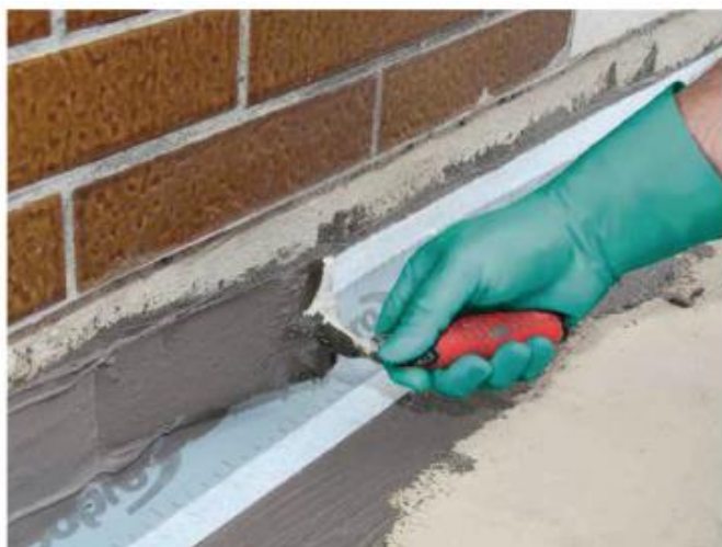
9 Na powierzchnię taśmy uszczelniającej Sopro DBF 638 obficie nałożyć masę uszczelniającą Sopro TDS 823.
