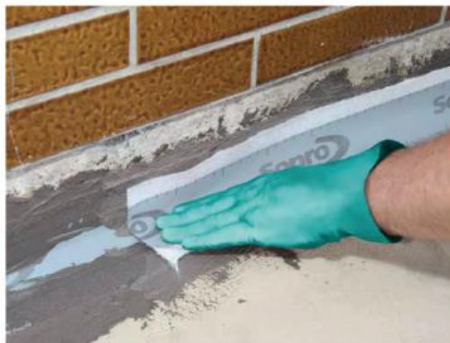
8 ... taśmy uszczelniającej Sopro DBF 638. Taśmę dodatkowo docisnąć do podłoża.
