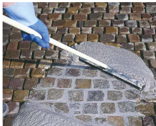
5 Wypełnienie spoin zaprawą fugową przy pomocy gumowej rakli.
