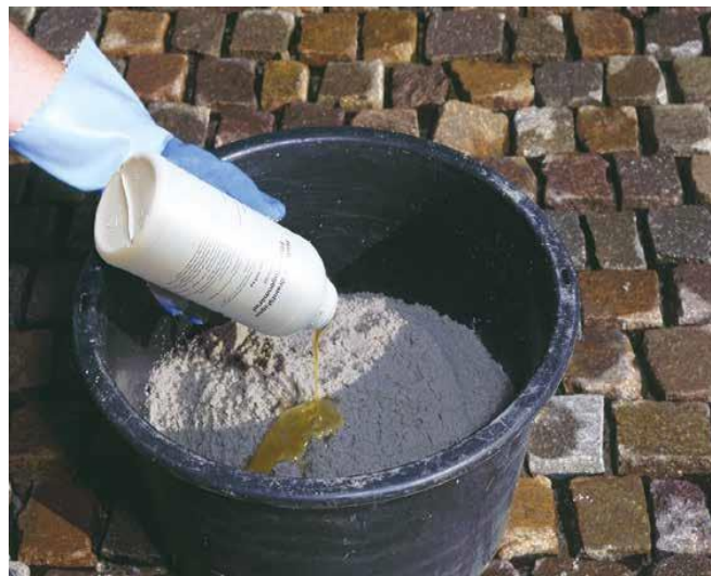
2 Dodawanie utwardzacza (składnik B) do mieszanki piaskowo-żywiczej (składnik A).
