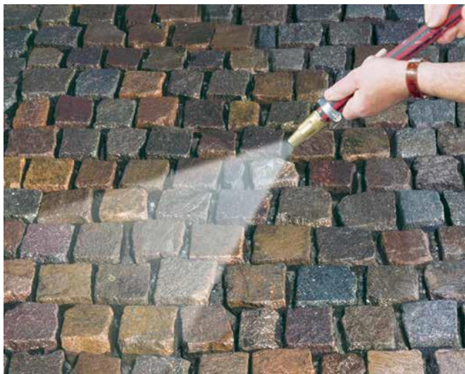
1 Nawilżona, wyczyszczona okładzina, przygotowana do spoinowania.
