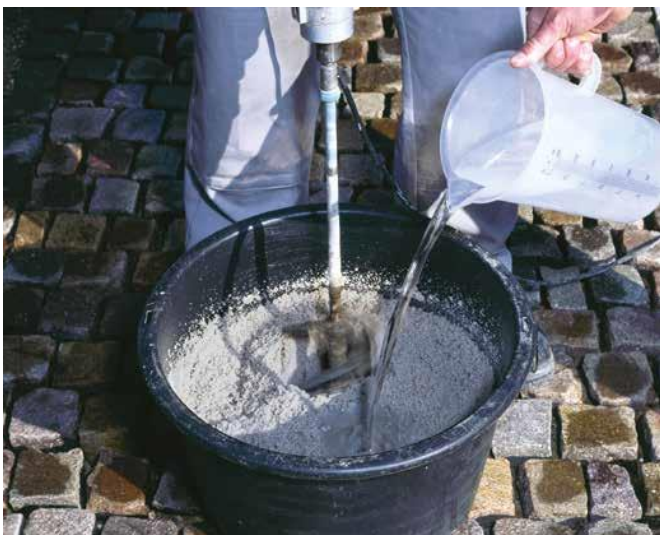
3 Wymieszanie fugi Sopro EPF z dodatkiem ok. 2 l wody.
