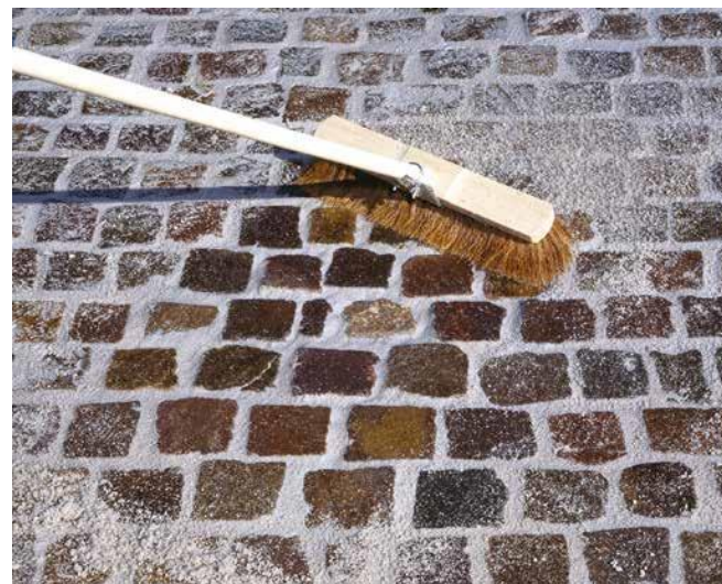
6 Oczyszczenie zaspoinowanej okładziny.
