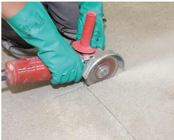
1 Jastrych naciąć przy pomocy szlifierki kątowej poprzecznie do szczeliny dylatacyjnej w rozstawie co 30-40 cm.
