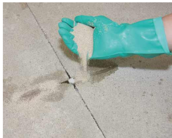
5 Nadmiar żywicy usunąć z powierzchni jastrychu. Następnie wypełnione zagłębienie obsypać piaskiem kwarcowym Sopro QS 511. Po związaniu żywicy nadmiar piasku usunąć.
