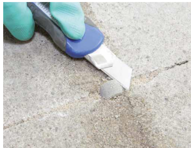
6 Ściąć wystający odcinek pianki.
