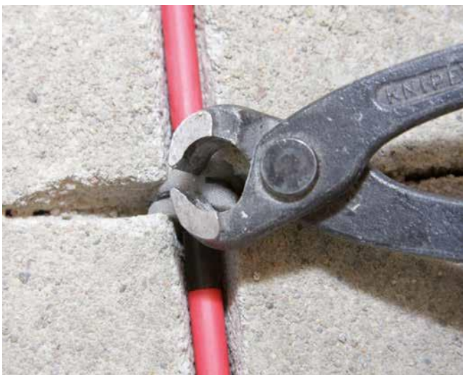
3 Pierścień z tworzywa sztucznego, trzymający piankę montażową, usunąć przy pomocy obcęwów.
