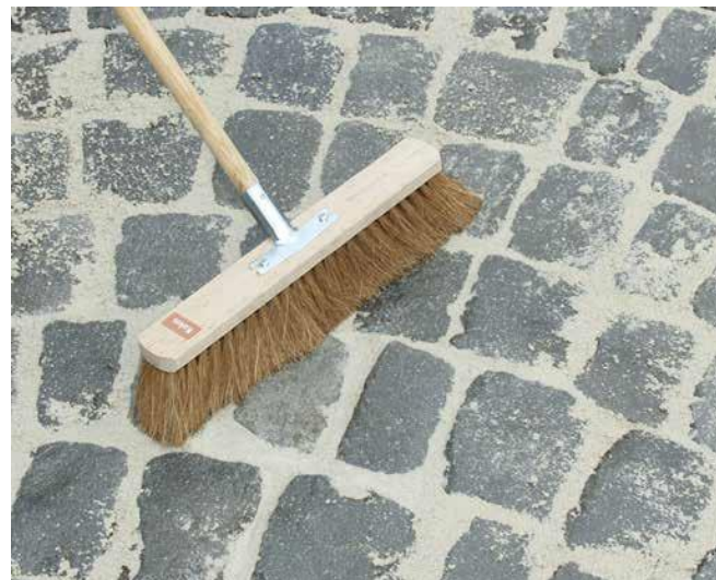
6 Oczyszczenie zaspoinowanej okładziny.
