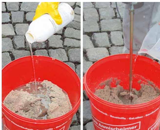
2 Dodawanie utwardzacza z dodatkiem maks. 2 l wody (składnik B) do mieszanki piaskowo-żywiczej (składnik A) i wymieszanie.
