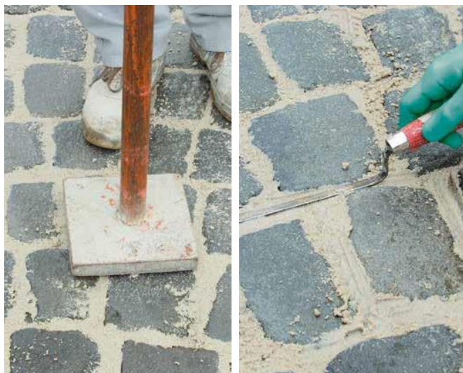
5 Intensywne zagęszczenie spoin przy pomocy ubijaka lub metalowej fugówki.
