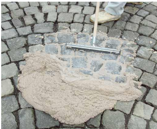
4 Wypełnienie spoin zaprawą fugową Sopro HFE przy pomocy gumowej rakli.
