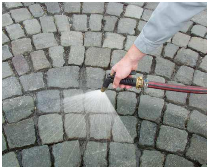
1 Nawilżona, wyczyszczona okładzina, przygotowana do spoinowania.
