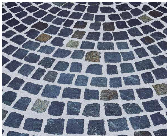
10 Gotowa, zafugowana nawierzchnia brukowa.
