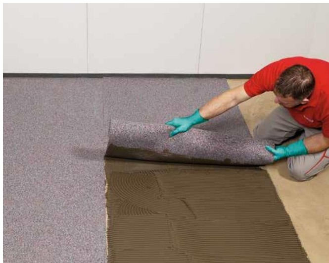
7 Następny element ułożyć ściśle obok sąsiadującej maty, na styk. Ważne jest, aby zaprawa klejowa nie wydostała się przez miejsca połączeń krawędzi mat.
