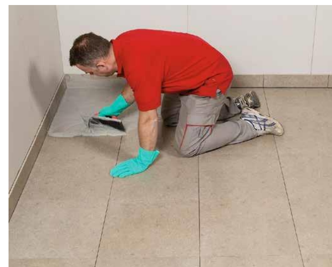
12 Po osiągnięciu możliwości chodzenia/fugowania okładzinę zaspoinować, np. Sopro DF 10*.
