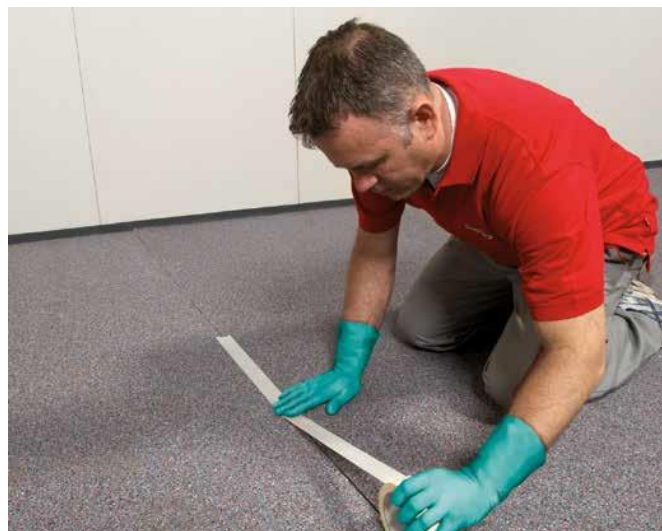
8 W celu wyeliminowania mostków akustycznych, spowodowanych zaprawą klejową, połączenia mat zakleja się papierową taśmą klejącą.
