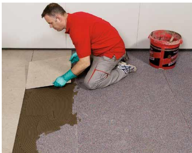
9 Po utwardzeniu zaprawy płytki ceramiczne można przykleić bezpośrednio do maty, stosując zaprawę klejową np. Sopro VF 419.
