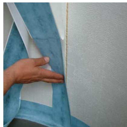
Usunąć folię, przyłożyć taśmę (bez naprężania) do podłoża i docisnąć – gotowe!
