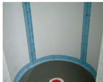
PCI Pecitape ® WS sprawdza się doskonale w miejscach o trudnej geometrii, np. w okrągłej kabinie prysznicowej.
