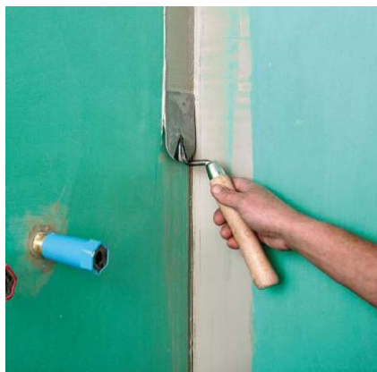
1. Nałożyć 1. warstwę uszczelnienia w miejscu wklejenia taśmy
