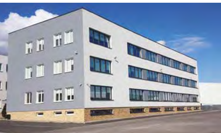
Nowe skrzydło biurowca Centrali PSB, Wełecz New part of the PSB Central Office building in Wełecz
