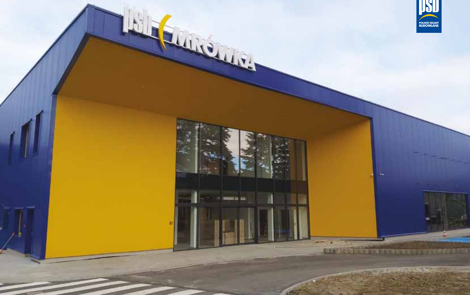
Budowa Mrówki w Andrychowie Construction of Mrówka outlet in Andrychów
