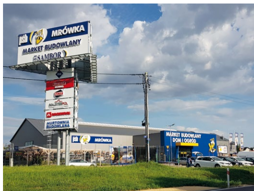
Pylon Mrówki w Kwidzynie / Pylon of Mrówka outlet in Kwidzyn
