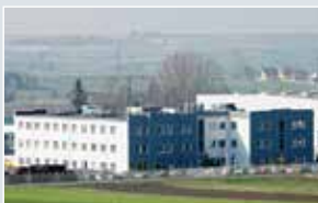
Rozbudowa biurowca Centrali PSB
