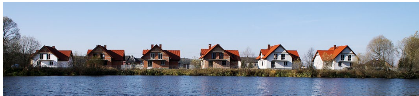
Budowa osiedla domów jednorodzinnych ROLBUDU
