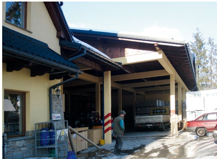
Powierzchnie magazynowe oddziału w Bukowinie dopełnia nowa wiat
