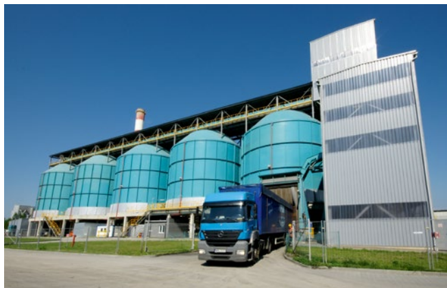
Instalacja współspalania paliw alternatywnych – silosy
