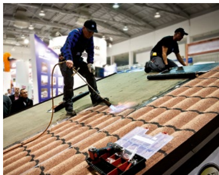
Pokaz kładzenia Rolowanej Dachówki Icopal 3D®
