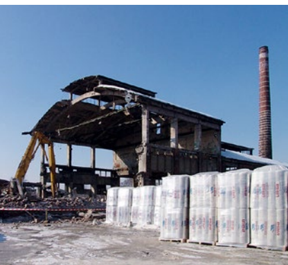
Zakład w Dąbrowie Górniczej. Rok 2001, pierwsza faza remontu
