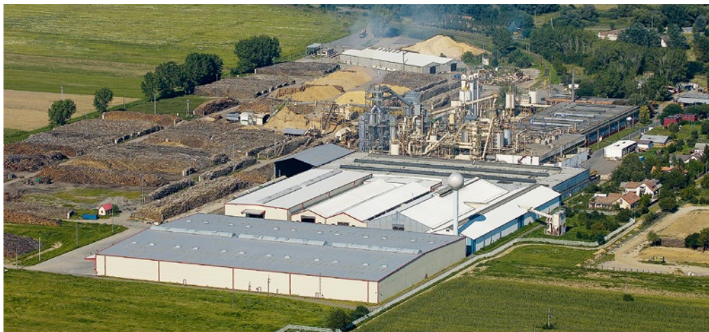
Fabryka w Żarach – widok ogólny
