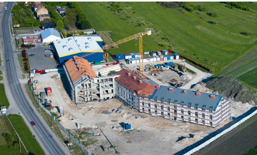
Hotel „Słoneczny Zdrój” w Busku-Zdroju (w budowie)
