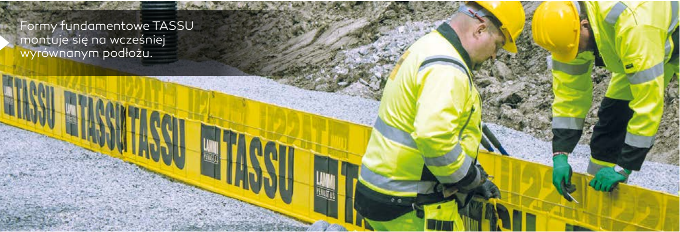
Po zmontowaniu szalunków i ewentualnym dodaniu zbrojenia dodatkowego, całość można zalać betonem.
