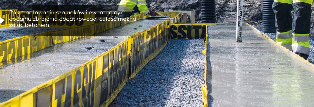
Po związaniu betonu szalunków nie demontujemy. Dzięki temu nie tracimy czasu i nie powstają uciążliwe odpady
