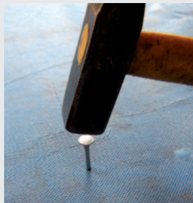
Montaż FEL'X Szybkiej Bariery SBS
